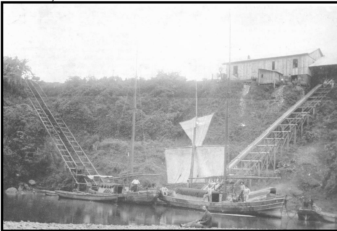
Figura 5 - Porto de General Osório (Muçum). Foto panorâmica dos trapiches e gasolinas (pequenas embarcações navais movidas a vela e motor) responsáveis pelo tráfego fluvial no porto de Muçum.
