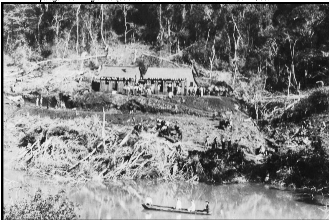
Figura 11 - Imigrantes trabalhando na abertura de estradas. Galpão às margens do rio Carreiro servindo de paragem aos imigrantes que trabalhavam na estrada 21 de Abril, em 1906.
