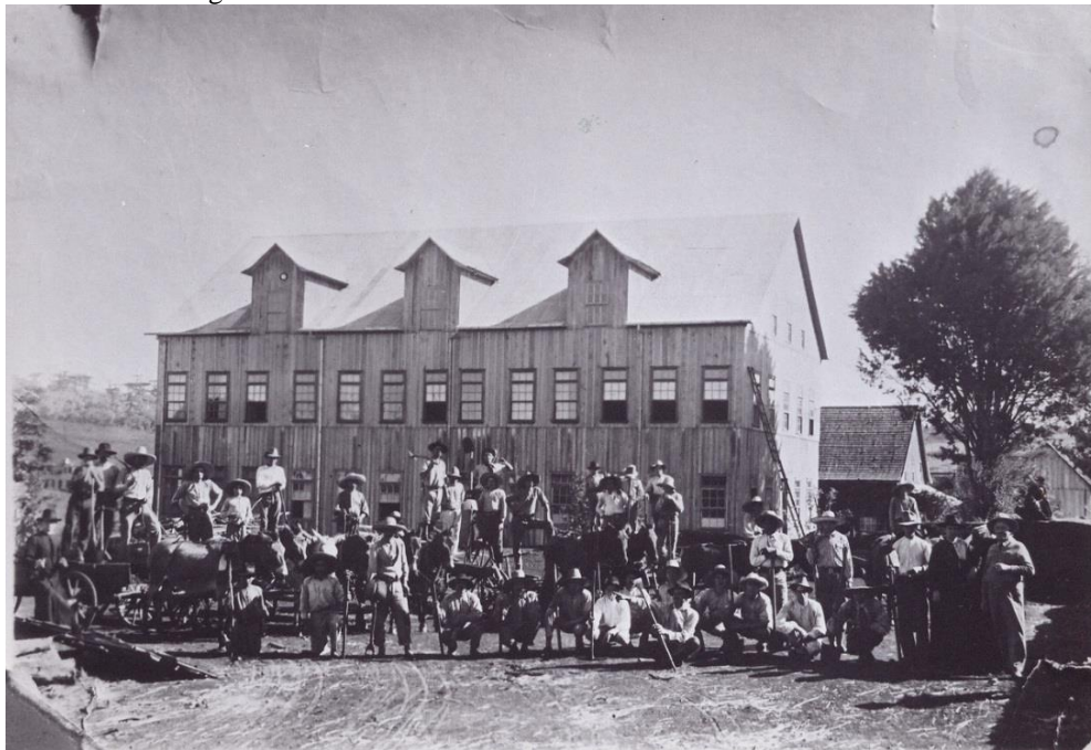
Figura 27 – Trabalhadores responsáveis pela obra de edificação da nova igreja em frente ao Colégio Santa Clara
