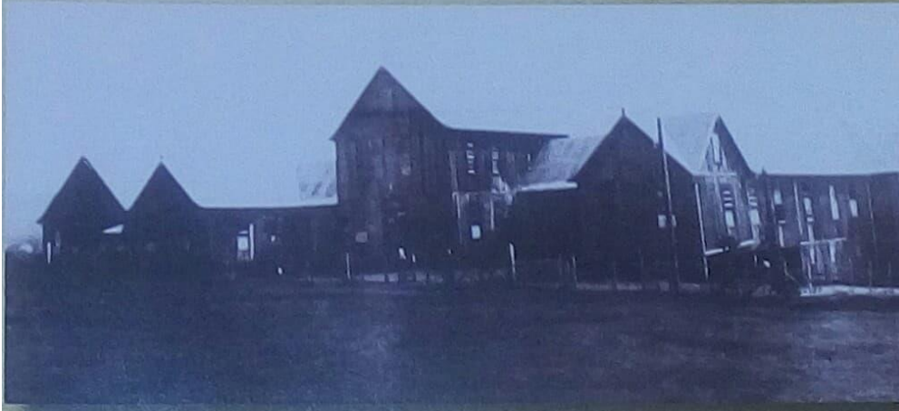
Figura 21 – Hospital São Roque
