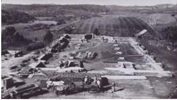
Figura 25 – Início da construção da igreja matriz
