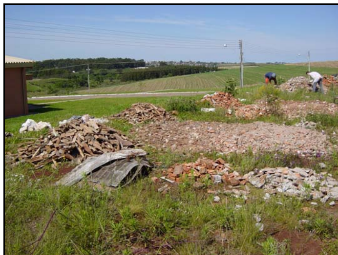
Figura 3.2.- Local onde foram armazenados os resíduos de construção e demolição.
