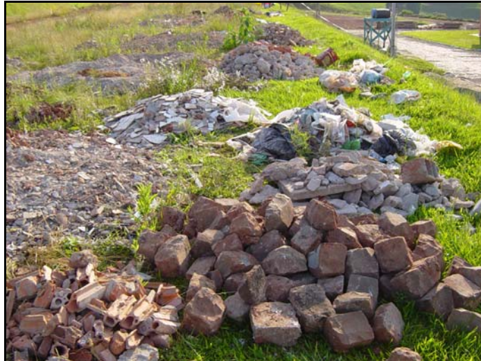
Figura 3.3- Resíduos já sendo classificados no local.
