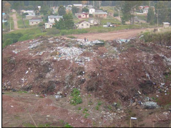
Figura 1.2- Aterro de resíduos do município de Passo Fundo de forma descontrolada e fora das normas vigentes.
