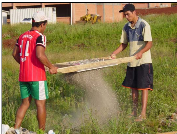
Figura 3.7- Resíduos sendo peneirados no local.
