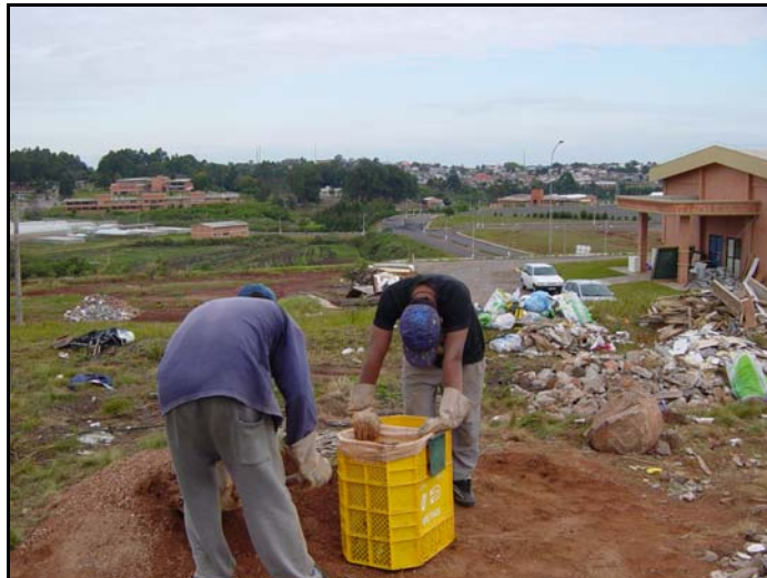
Figura 3.4- Resíduos sendo separados de forma manual e colocados em recipiente para pesagem.
