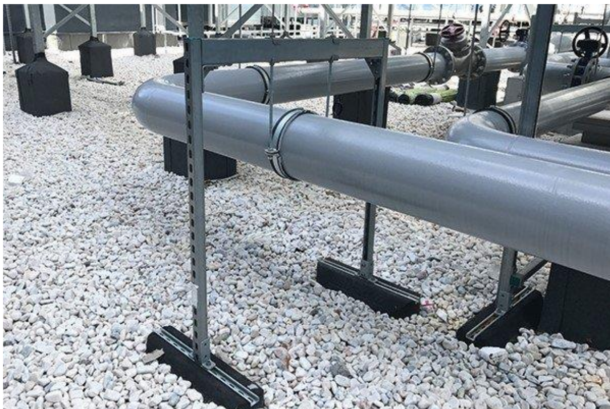
Figura 11: Suporte de tubulação semimóvel
