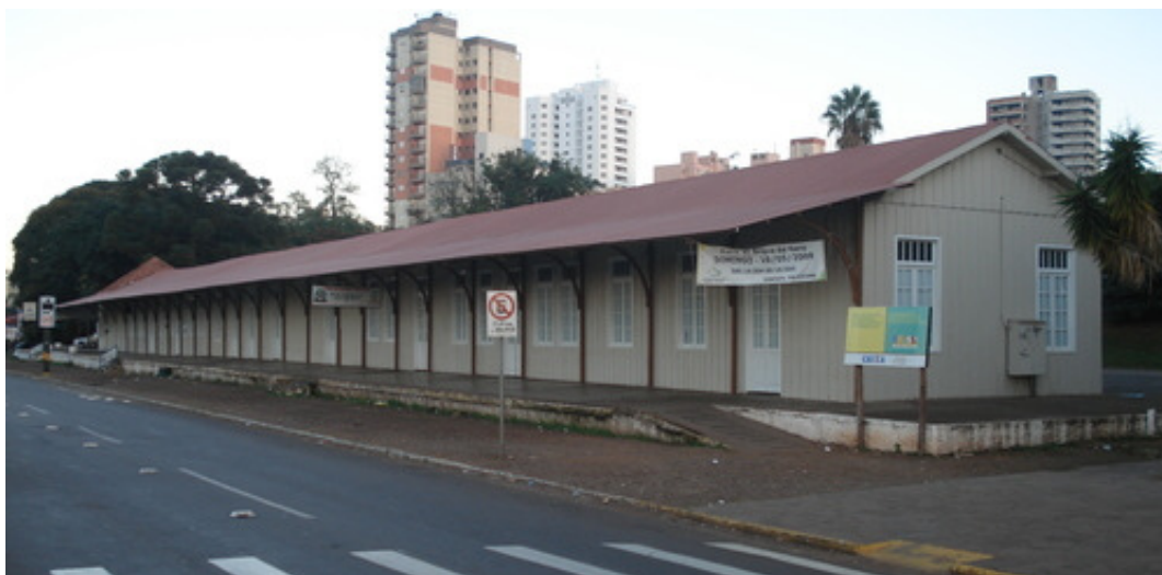
Figura 21: Prédio da Gare.
