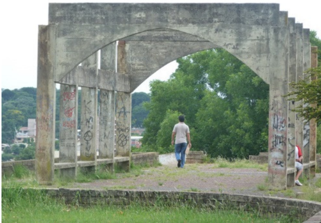
Figura 29: Ruínas da Gare.
