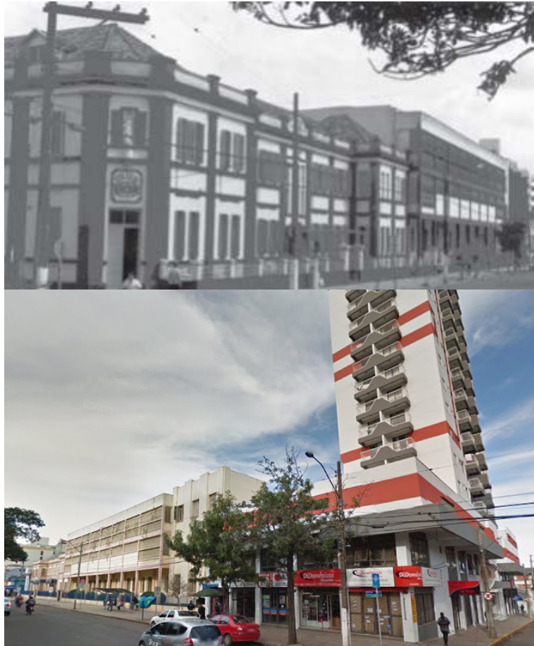
Figura 18: Colégio Notre Dame antes e depois da construção da edificação vizinha.
