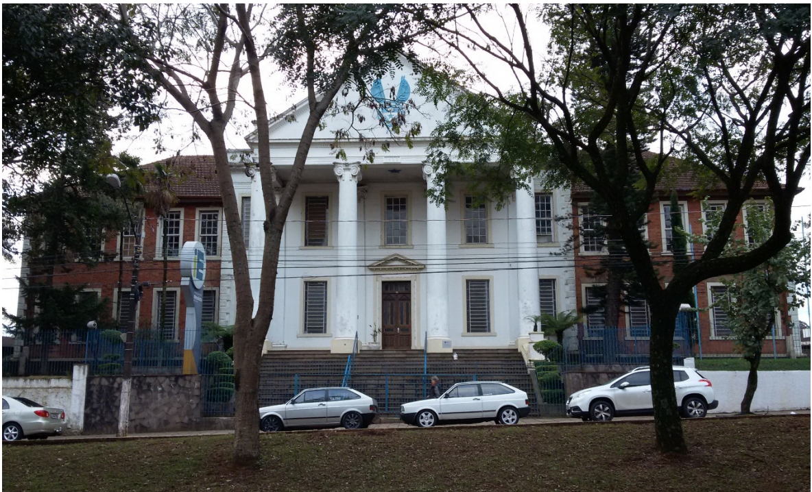
Figura 17: Prédio Texas do Instituto Educacional. Fonte: elaborada pela autora
