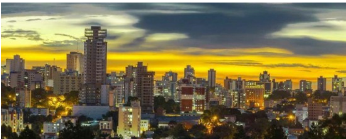
Figura 34: Residencial Abu Dhabi em construção, na imagem é o edifício mais alto. Fonte: CIGS Construtora. Autor: não indicado na fonte original
