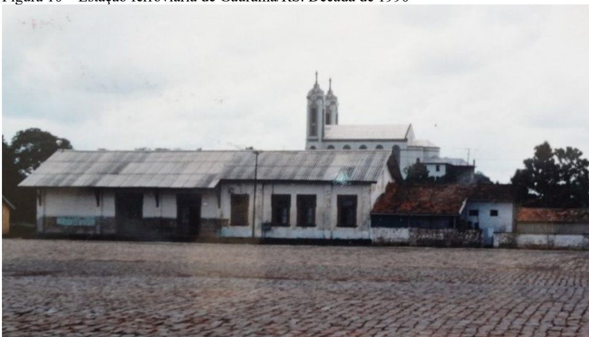
Figura 10 – Estação ferroviária de Gaurama/RS. Década de 1990
