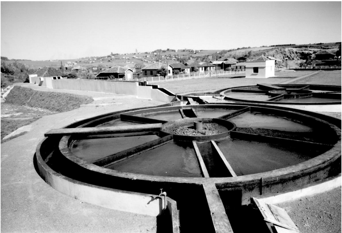
Figura 10: Antiga Estação de Tratamento de Esgotos localizada na Vila Annes
