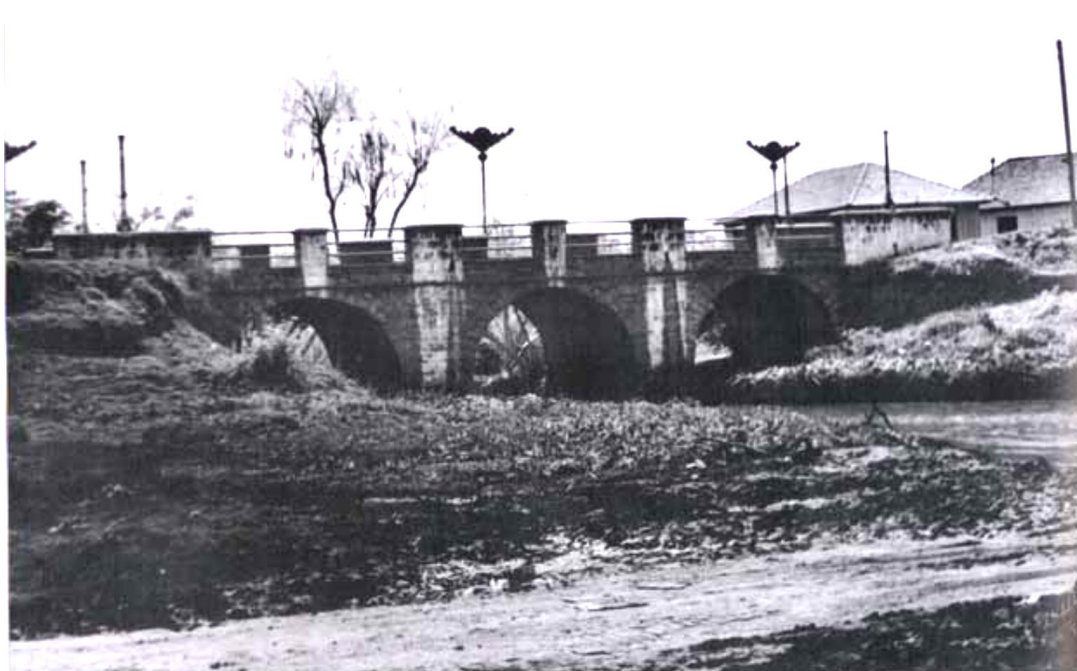
Figura 1: Ponte de pedra sobre o Rio Passo Fundo, construída entre 1926 e 1928
