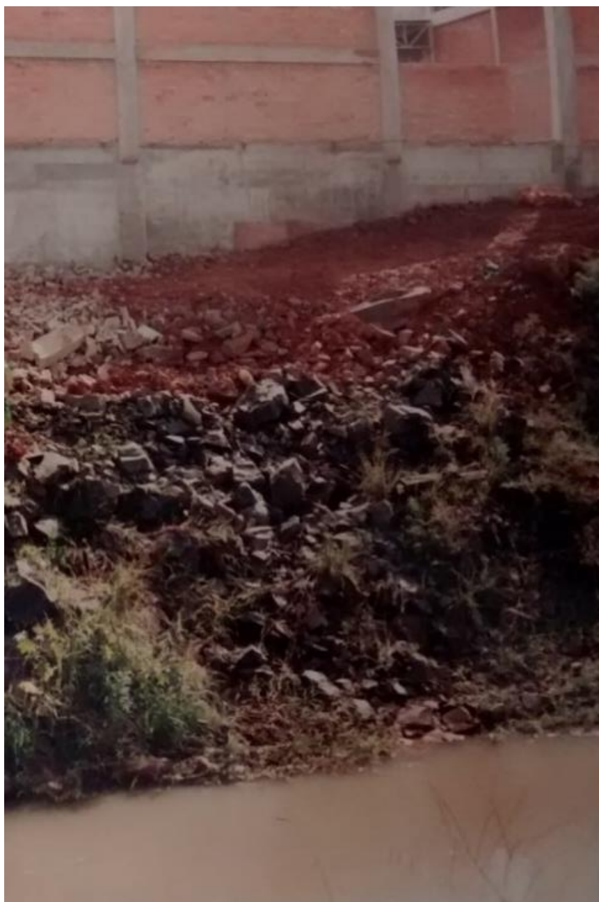
Figura 23: Proximidade da construção do leito do rio
