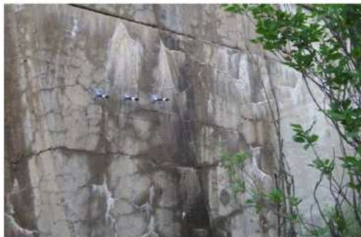
Figura 5: Reação álcali-sílica
