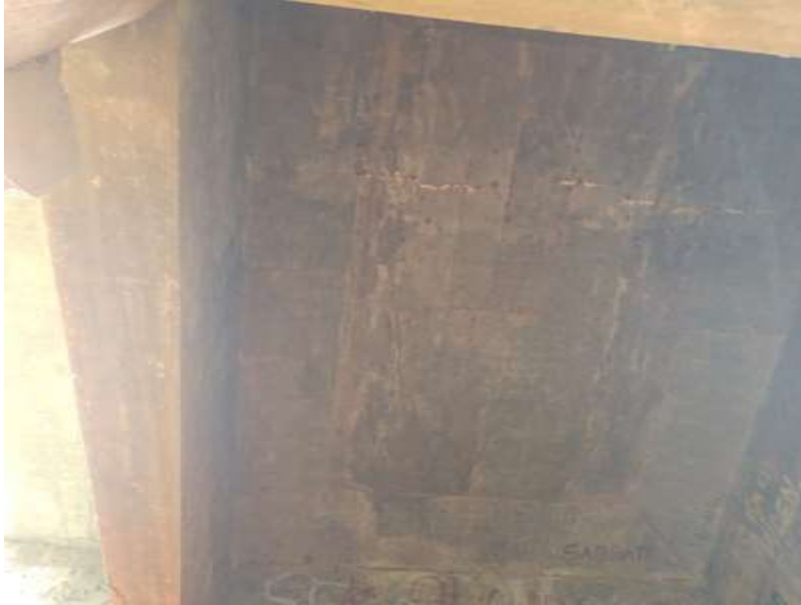
Figura 118: V2 - Eflorescência e corrosão no tabuleiro
