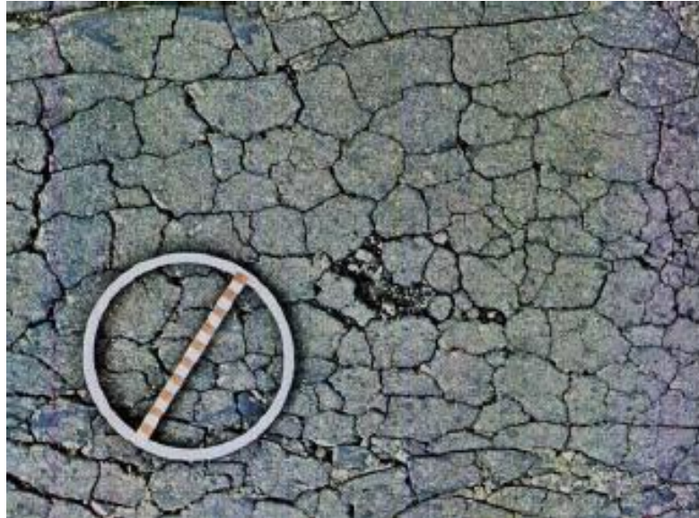
Figura 2: Trincamento por fadiga (tipo couro de crocodilo).
