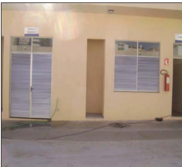
Figura 42: Local destinado ao armazenamento externo dos resíduos localizado nos fundos do
