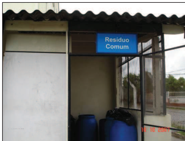
Figura 24: Armazenamento externo do resíduo comum no hospital C, 2007.
