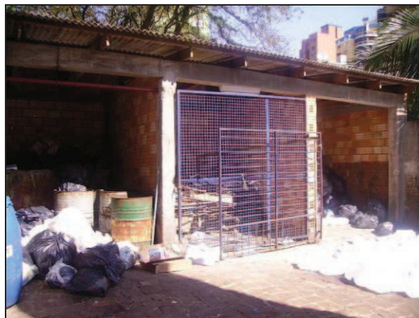
Figura 19: Armazenamento externo feito em abrigo sem condições adequadas de segurança e limpeza - hospital B, 2007.
