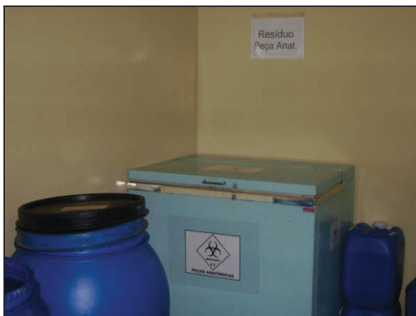
Figura 13: Armazenagem de peças anatômicas no hospital A em freezer localizado no abrigo: uso de cartaz para identificar o tipo de RSS e adesivo com simbologia específica, 2007.
