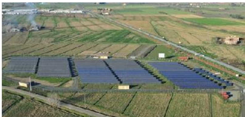
Figura 57: Painéis Fotovoltaicos para produção de eletricidade em La Fila
