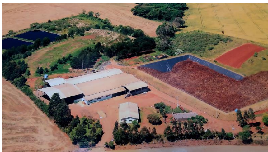
Figura 43: Vista aérea das instalações do CONIGEPU
