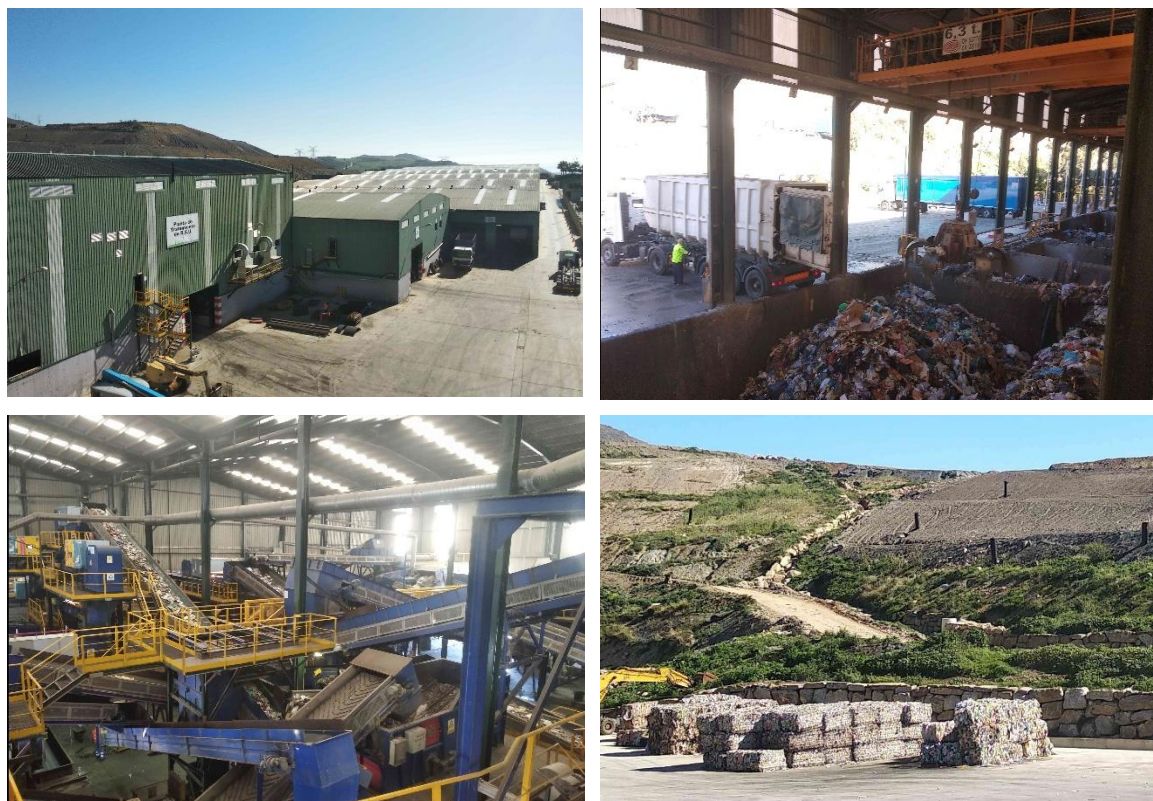
Figura 74: Planta de Tratamento de Resíduos da Mancomunidad Costa del Sol
