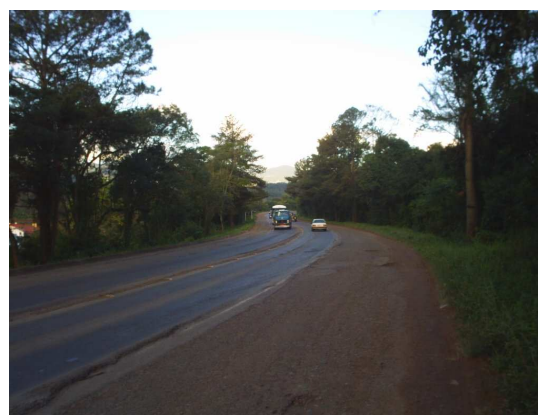
Figura 29: Foto da Rodovia RS-122 antigo traçado – trecho de maior extensão (2006)
