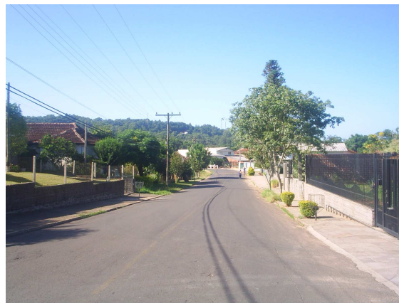
Figura 23: Foto da via secundária de menor perfil transversal - Estrada da Várzea (2006)
