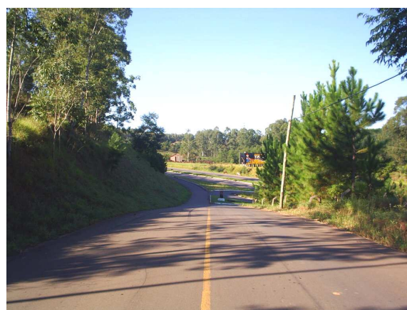
Figura 17: Foto da Av. Nelson Hoff – ausência de passeios vista para o acesso à RS-122
