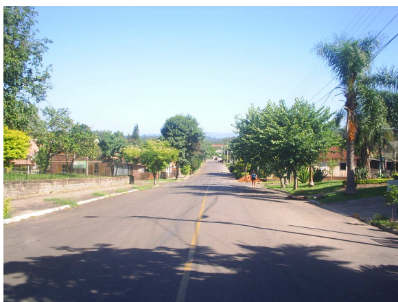
Figura 26: Foto da via principal de menor perfil transversal – Rua do Parque (2006)
