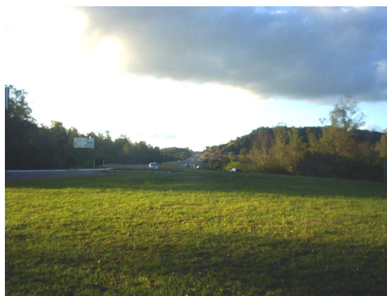
Figura 19: Foto do novo traçado (variante) da RS-122 vista da Rótula Sul para a estrada do Angico
