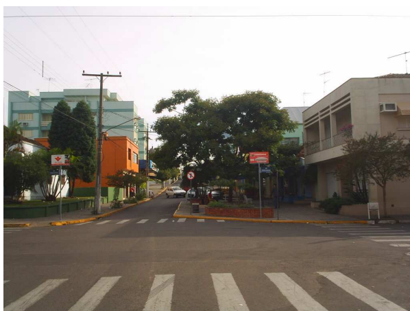
Figura 34: Foto da rampa de passeio – Rua Mal. Deodoro da Fonseca eq. Rua Pinheiro Machado (2006)
