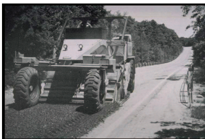
Figura 7 - Recuperação da rodovia usando FDR
