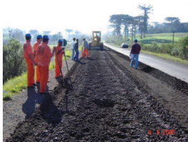
Figura 52 – Regularização do material reciclado
