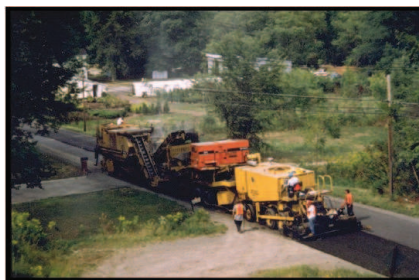
Figura 4 – Reciclagem a frio in situ
