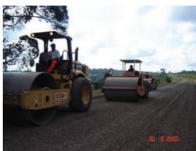
Figura 53 – Compactação da base reciclada
