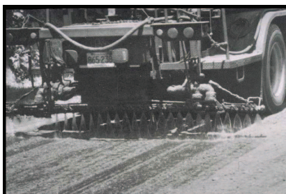
Figura 7 - Recuperação da rodovia usando FDR
