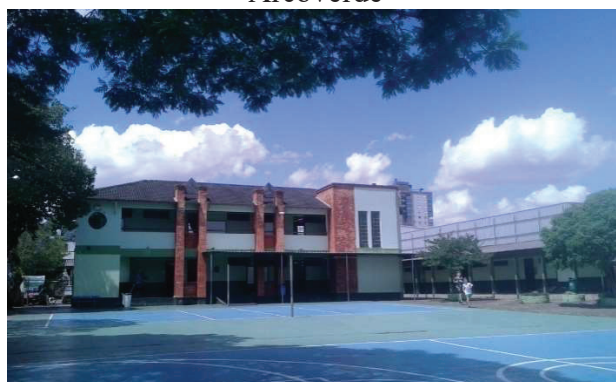
Figura 3 – Vista do pátio interno da Escola Arcoverde
