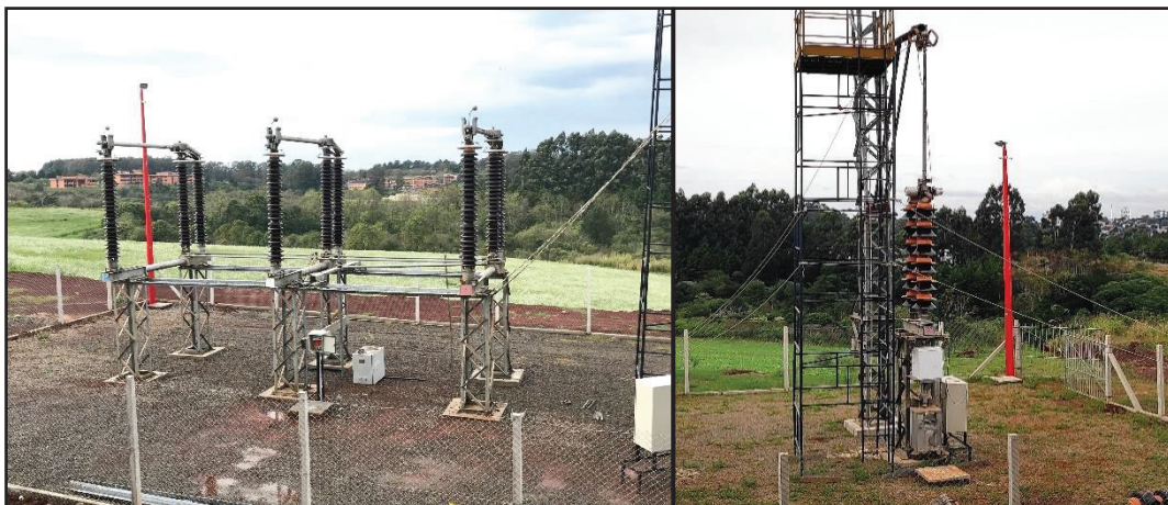
Figura 2 - Chaves seccionadoras Lorenzetti EV 242 kV (à esquerda) e Harvey Hubble BMKU-40A (à direita)
