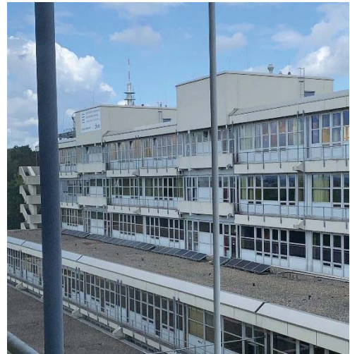
(b) Parte da área de geração solar fotovoltaica no Campus Bergedorf
