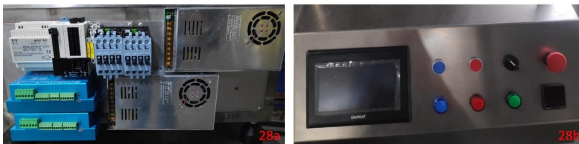
Figura 28 - Montagem painel elétrico
