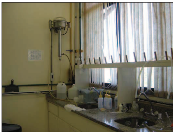
Figura 28: Pias para lavagem do material no laboratório de efluentes - Eng. Alimentos/CEPA - FEAR..
