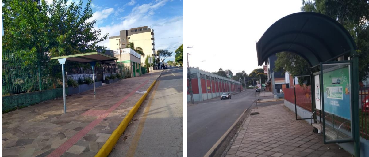
A) Parada de ônibus em condições ruins, sem banco e lixeira.
