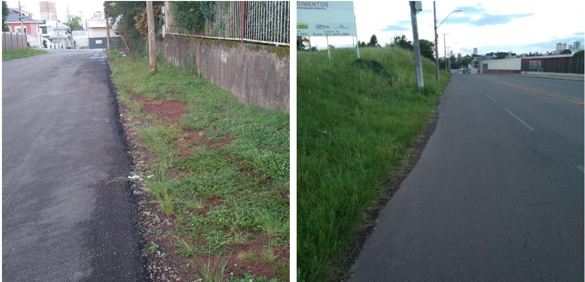
E) Calçada com IQC = 2,00 sem pavimentação
