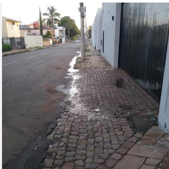
D) Calçada com IQC = 3,57 e interferência do escoamento no fluxo de pedestres.
