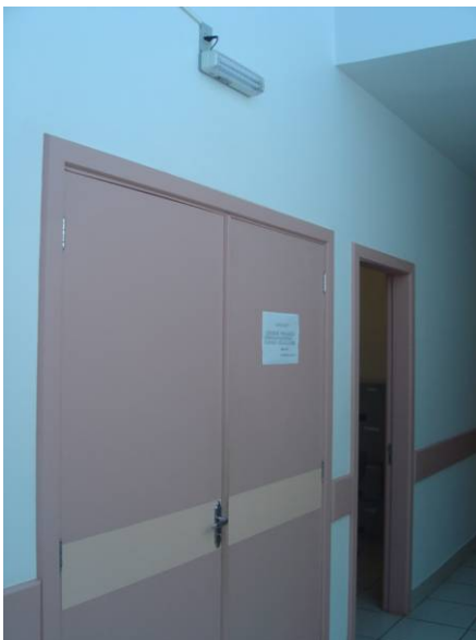
Figura 136 – Iluminação de emergência sobre o acesso entre a circulação social e a sala de espera.
