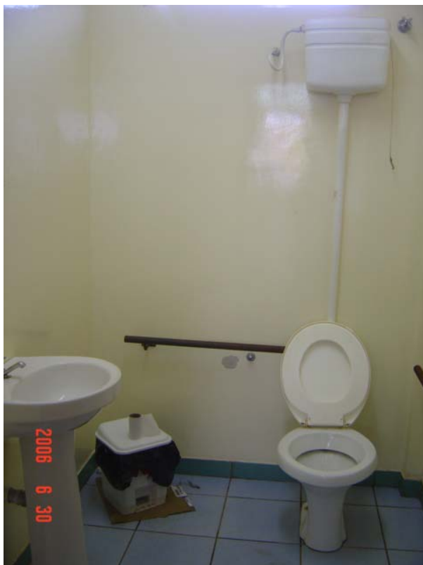
Figura 50 – Aspecto do banheiro público masculino / adaptações desconformes a NBR 9050.
