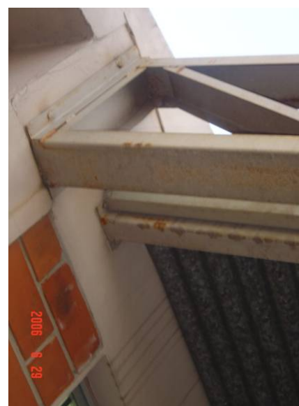
Figuras 36 e 37 – Pórtico de acesso do CAIS Dr. Cyrio Nácul. Observam-se os sinais de oxidação ocasionados pela corrosão galvânica e pela falta de manutenção.
