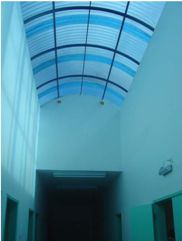
Figura 88 – Clarabóia em telhas de fibra de vidro apoiadas em estrutura metálica.
