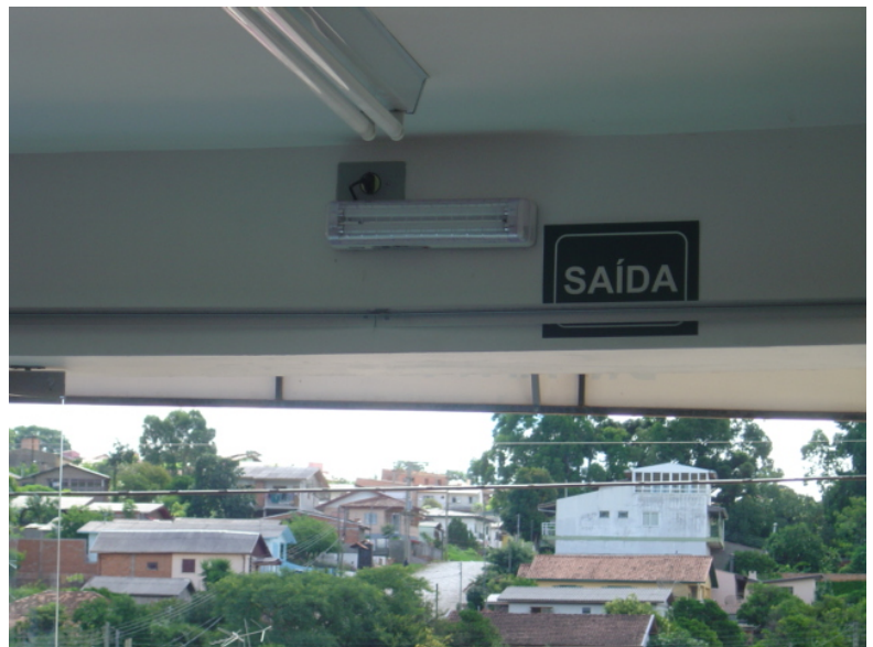
Figura 136 – Iluminação de emergência sobre o acesso entre a circulação social e a sala de espera.
