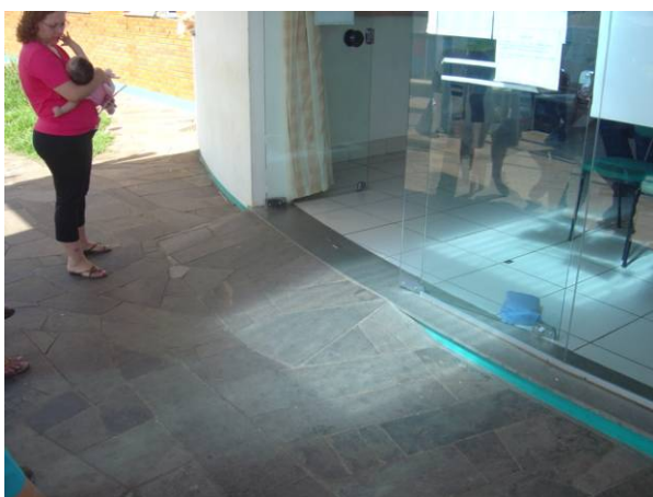
Figura 132 – Rampa de acesso principal / declividade desconforme a NBR 9050.
