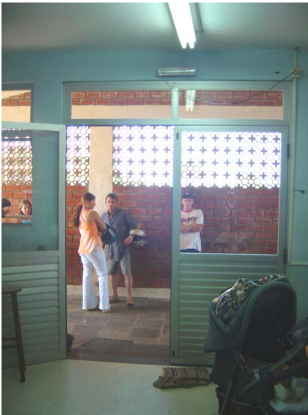
Figura 31 – Porta de acesso principal com bloco autônomo de iluminação de emergência.
