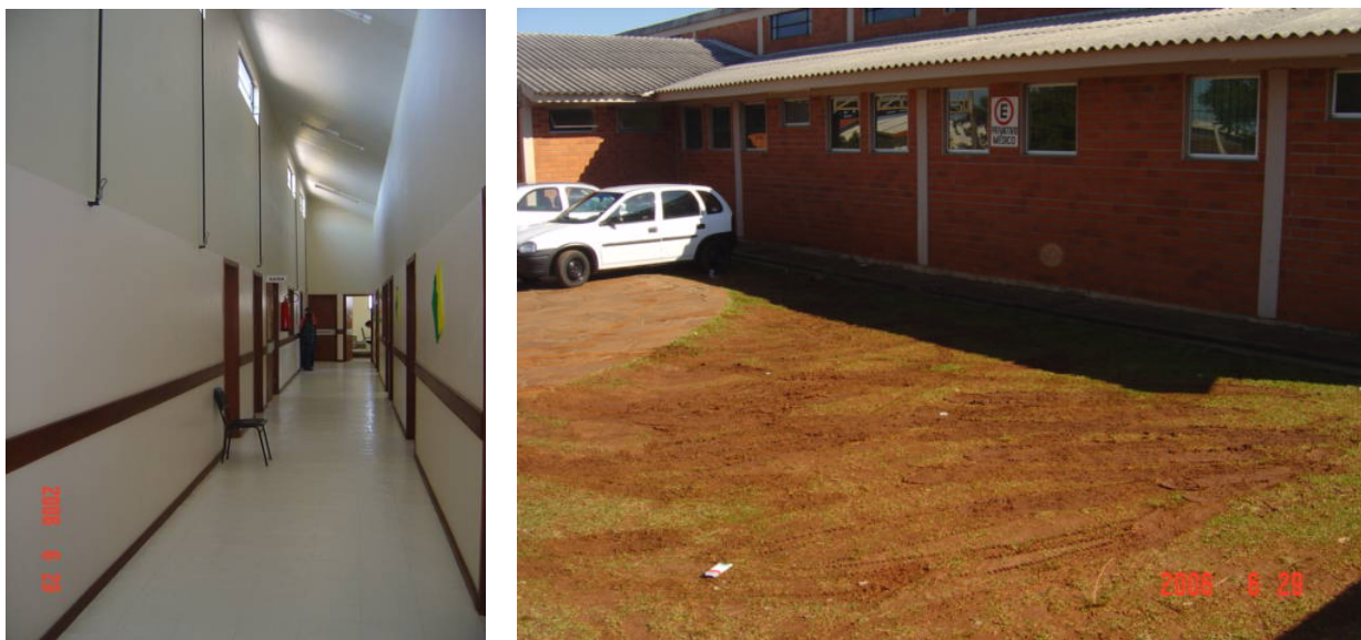
Figura 38 – Circulação social com iluminação e ventilação por meio de sheds.
