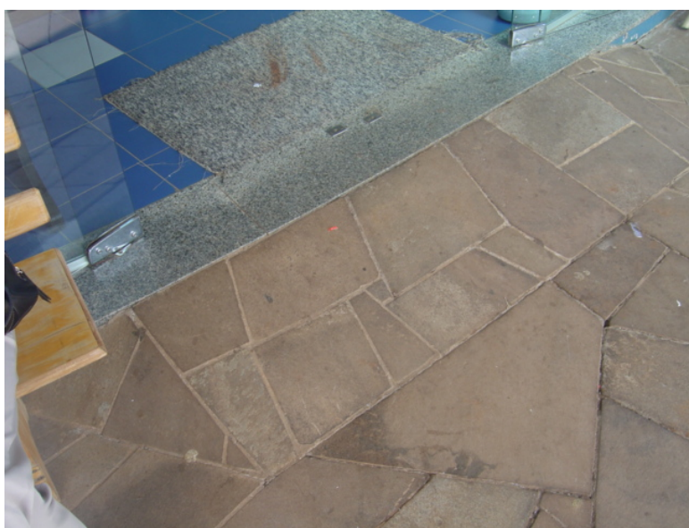
Figura 103 – Rampa de acesso principal / declividade desconforme a NBR 9050.
