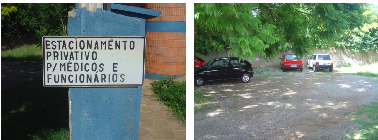
Figura 90 e 91 – Estacionamento privativo improvisado / área excessiva / pavimentação inadequada.
