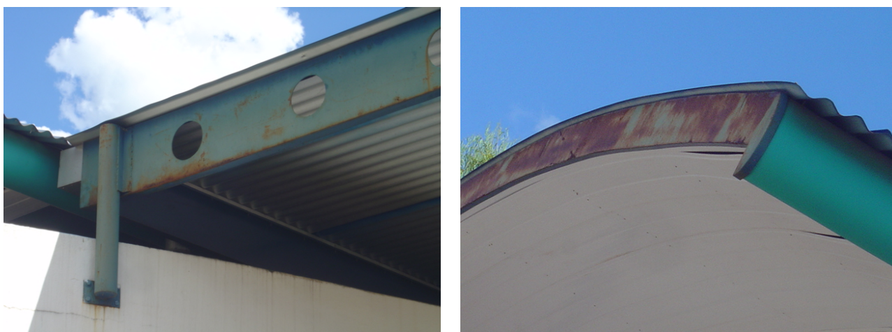
Figuras 117 e 118 – Pórtico de acesso e beiral da cobertura do CAIS Dr. Antônio Marinho Albuquerque.
