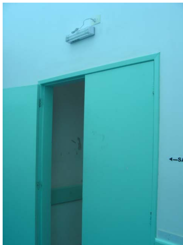
Figura 107 – Iluminação de emergência sobre a saída de serviços.
