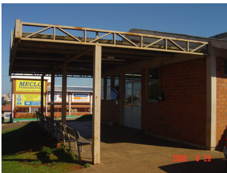
Figuras 36 e 37 – Pórtico de acesso do CAIS Dr. Cyrio Nácul. Observam-se os sinais de oxidação ocasionados pela corrosão galvânica e pela falta de manutenção.
