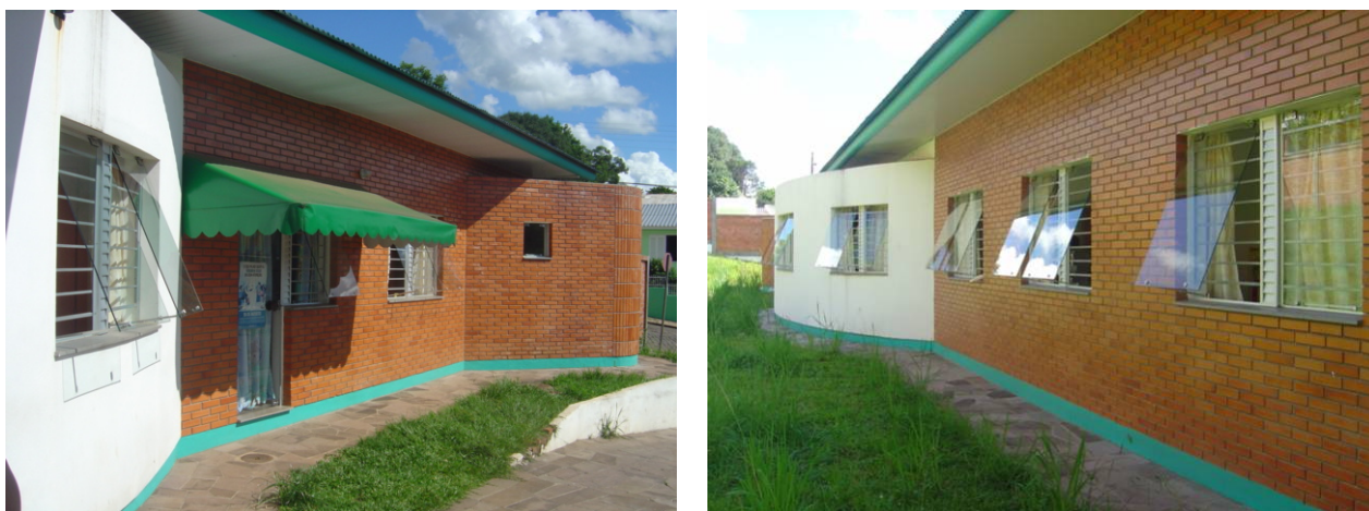
Figura 125 – Acesso externo à sala de vacinação / toldo para proteção da irradiação solar norte e noroeste.
