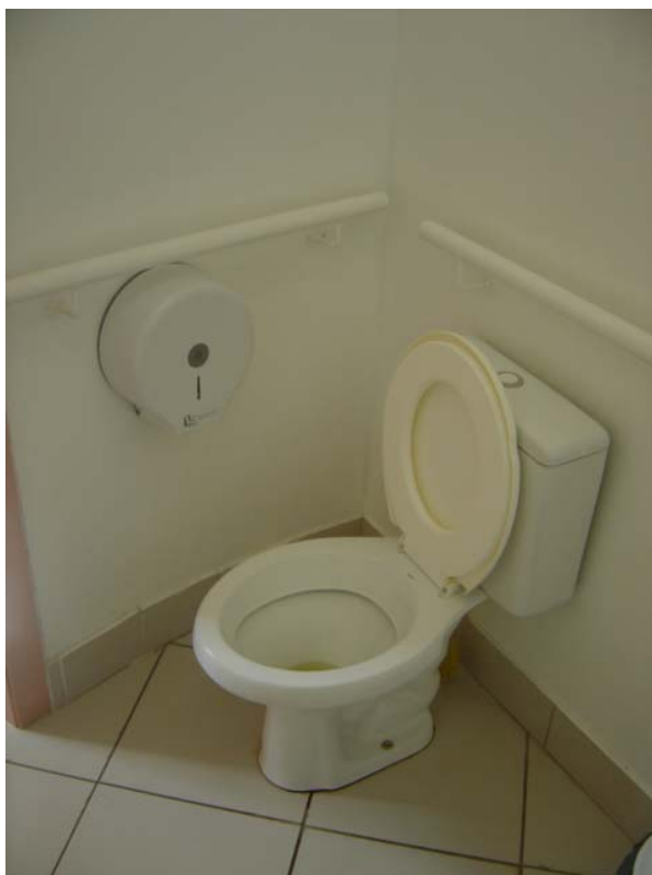
Figuras 134 e 135 – Aspecto dos sanitários públicos / adaptações desconformes a NBR 9050.
