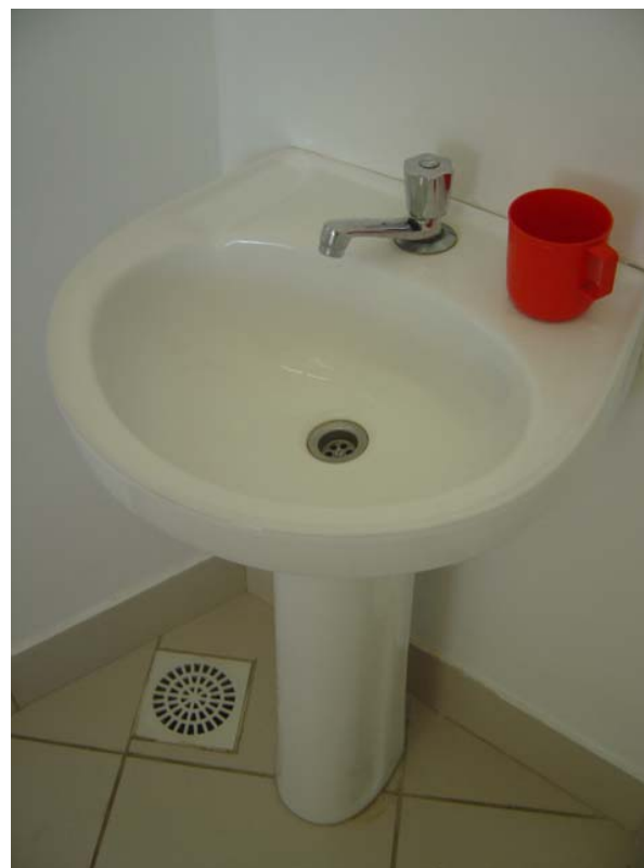
Figuras 134 e 135 – Aspecto dos sanitários públicos / adaptações desconformes a NBR 9050.
