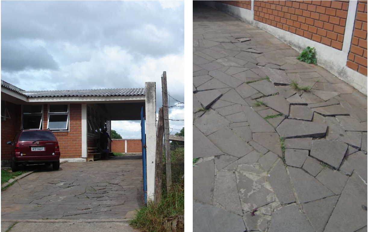
Figura 18 – Acesso principal dividido entre carros e pedestres / ao fundo o espaço destinado ao estacionamento.
