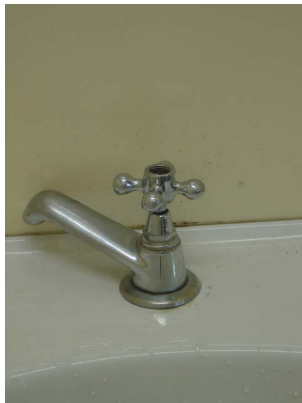
Figura 50 – Aspecto do banheiro público masculino / adaptações desconformes a NBR 9050.
