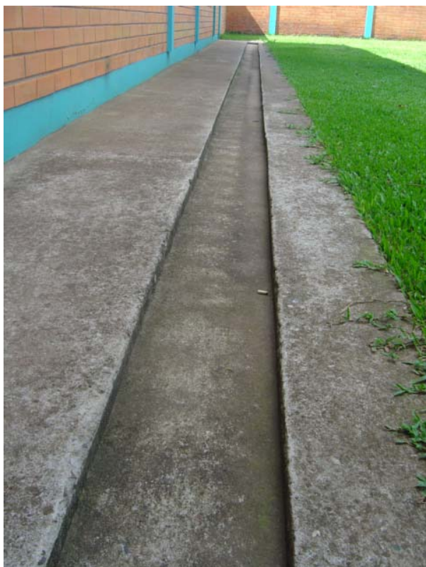
Figura 61 – Aparência das valas de recolhimento pluvial e passeios periféricos.
