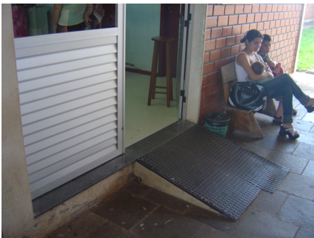
Figura 27 – Rampa de acesso principal / declividade desconforme a NBR 9050.
