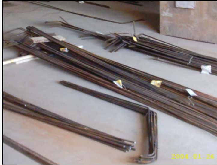
Figura 22 – Aço cortado e dobrado pelo fabricante
