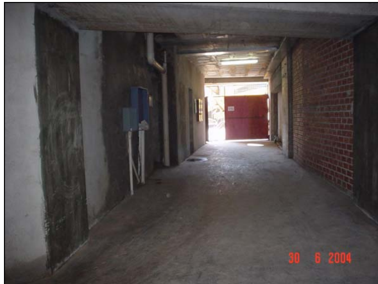
Figura 13 - Registros do canteiro de obras com implementação do layout
