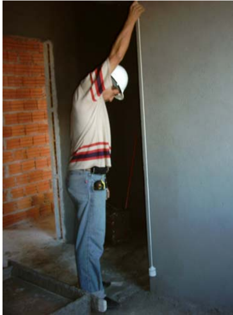
Figura 16 - Inspeção de serviço controlado
