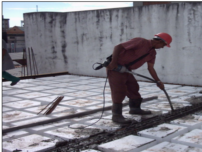
Figura 15 - Trabalhador utilizando o vibrador portátil
