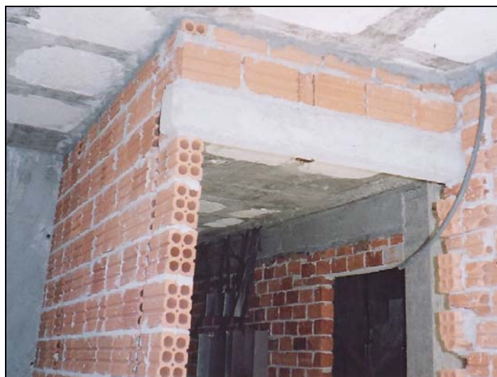
Figura 24 - Utilização das vergas pré-moldadas
