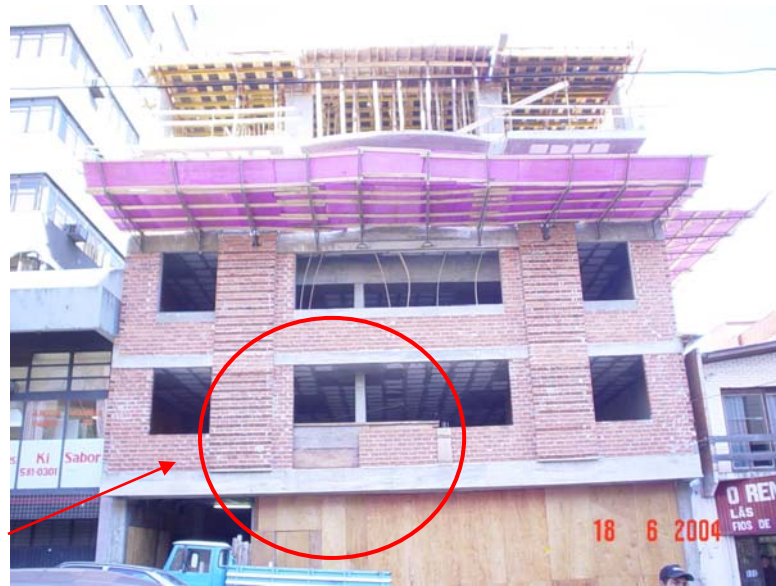
Figura 37 - Acesso ao segundo pavimento
