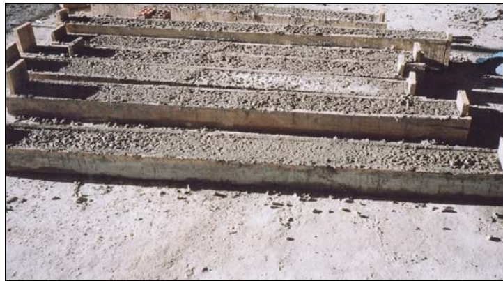
Figura 23 - Pré-moldagem das vergas
