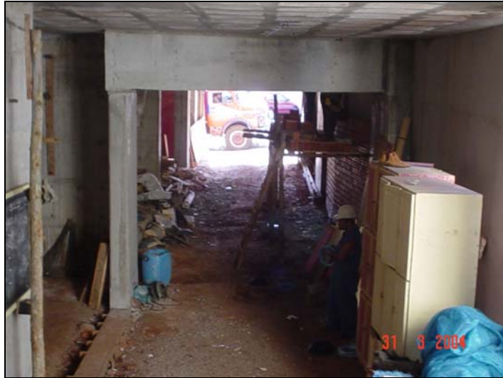
Figura 12 - Registros do canteiro de obras antes da intervenção
