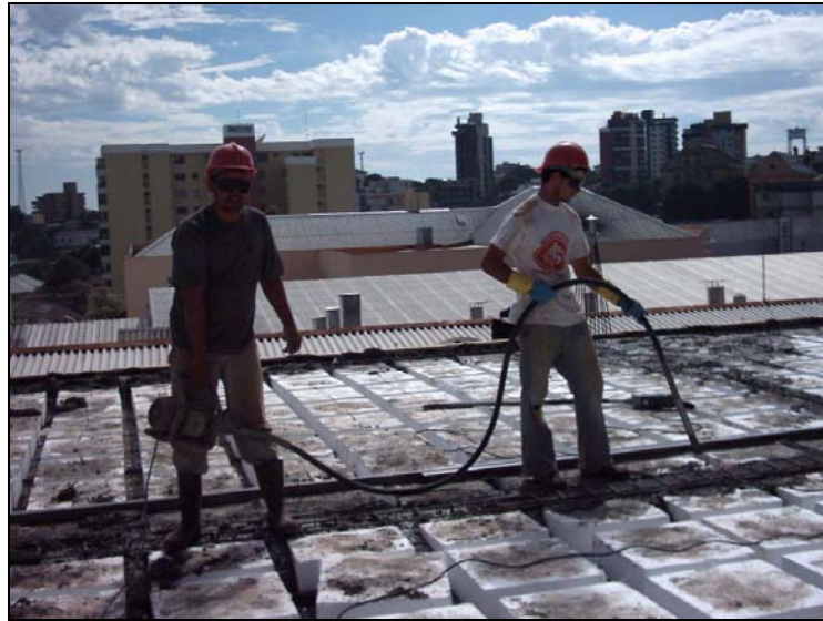
Figura 14 - Trabalhador utilizando o antigo vibrador
