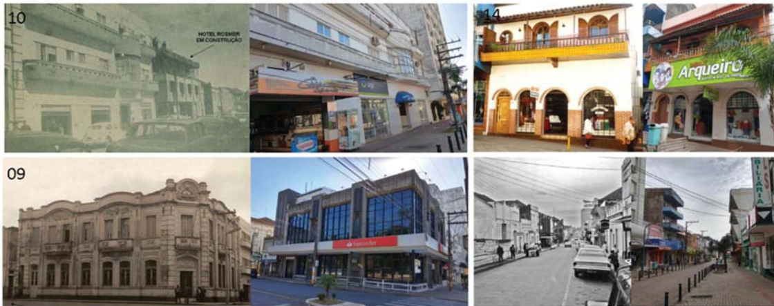
Figura 79 – Edificações à oeste – perfil viário 01
