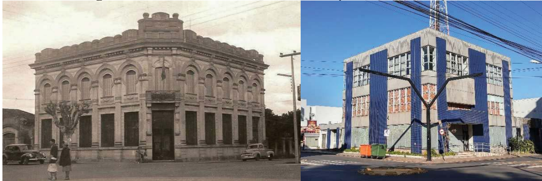
Figura 40 – Banco Pelotense substituído por nova edificação
