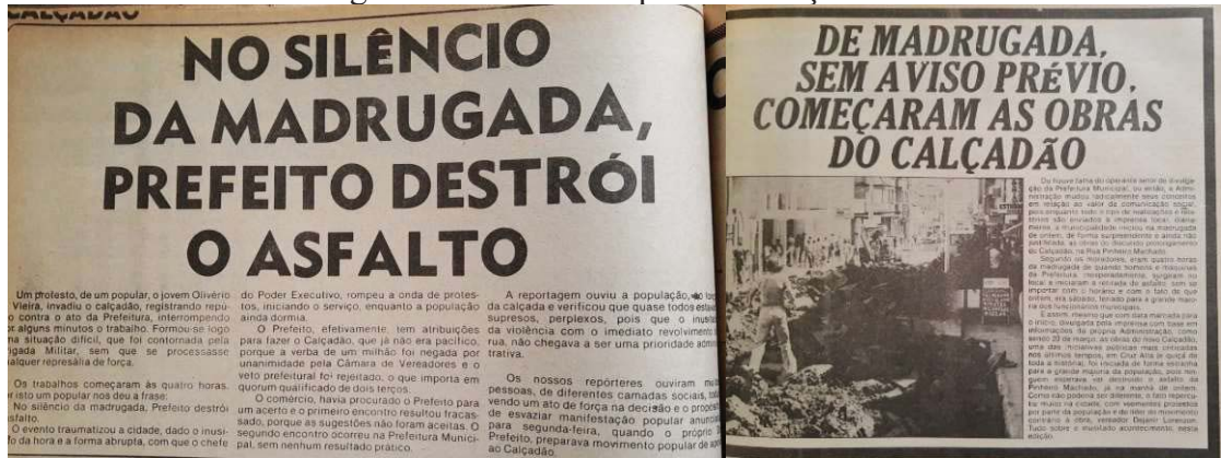
Figura 60- Obra antecipada do Calçadão 2
