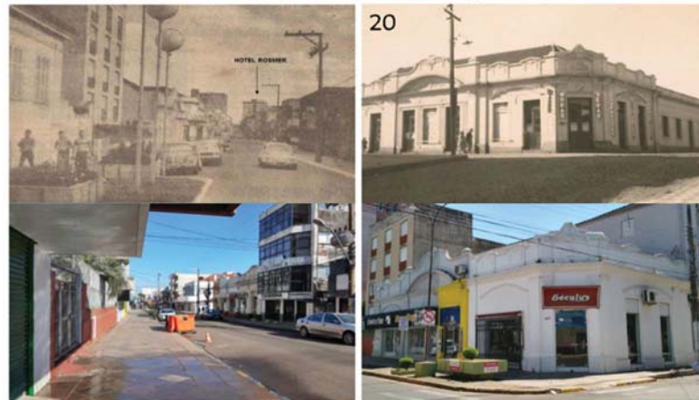
Figura 91 – Edificações à oeste – perfil viário 04
