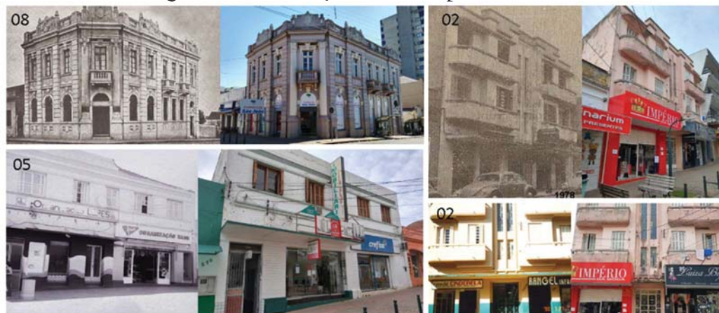
Figura 78 – Edificações à leste – perfil viário 01
