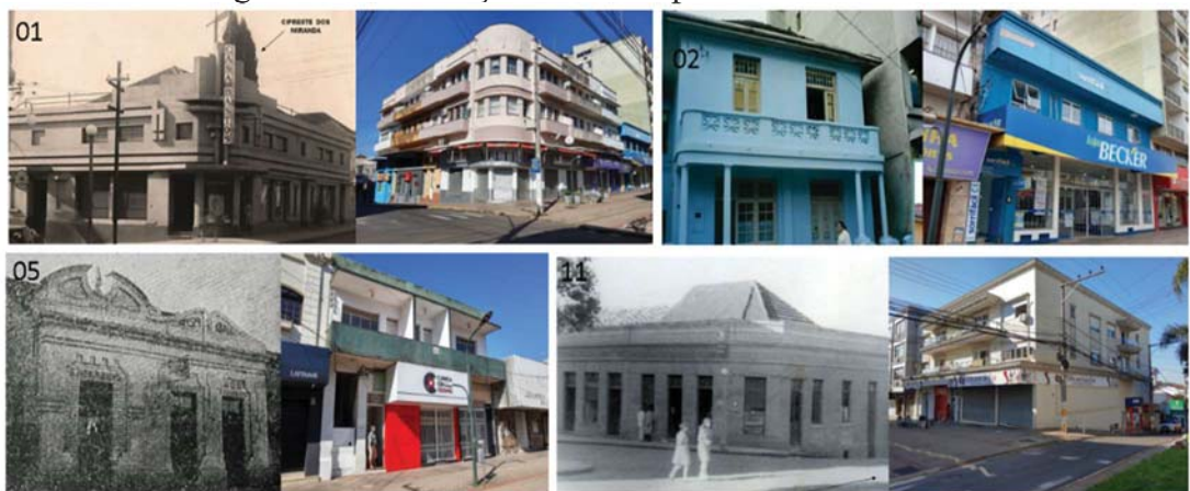
Figura 82 – Edificações à leste – perfil viário 02
