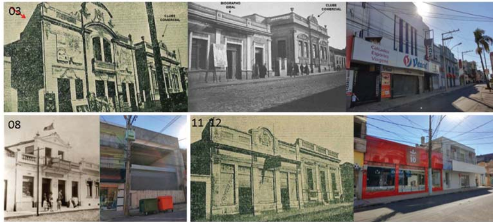
Figura 86 – Edificações à leste – perfil viário 03
