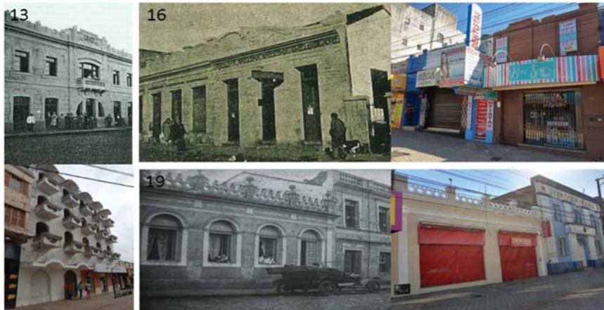
Figura 83 – Edificações à oeste – perfil viário 02
