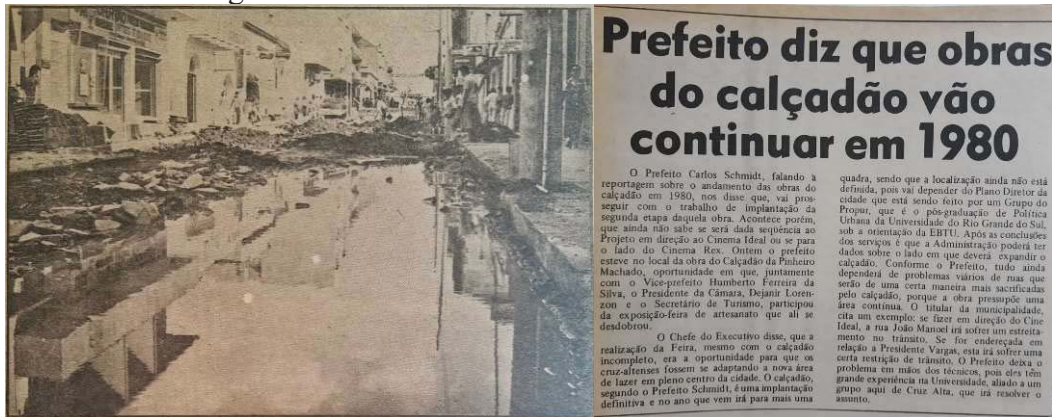
Figura 54- Obras na Rua Pinheiro Machado
