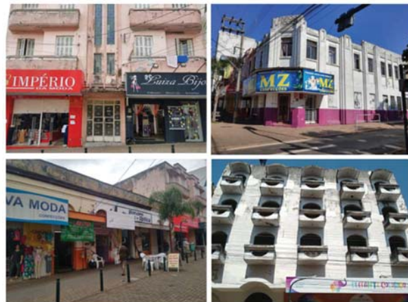
Figura 93 – Estado instável de conservação de edificações
