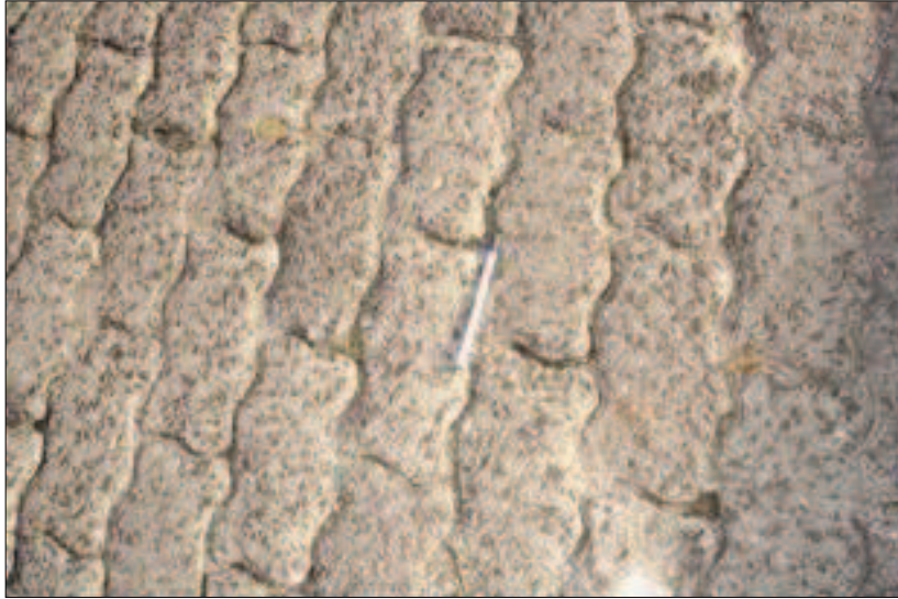
Figura 10 – Pavimento de PPCs
