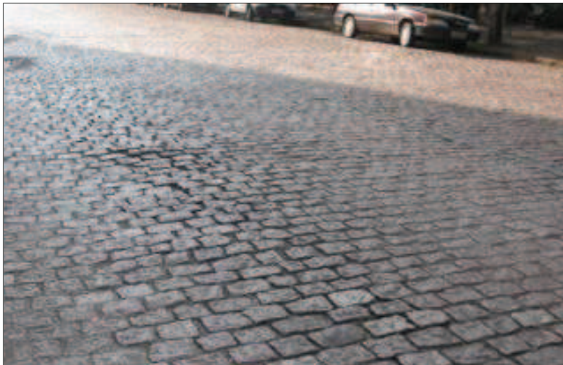
Figura 11 – Pavimento de paralelepípedos
