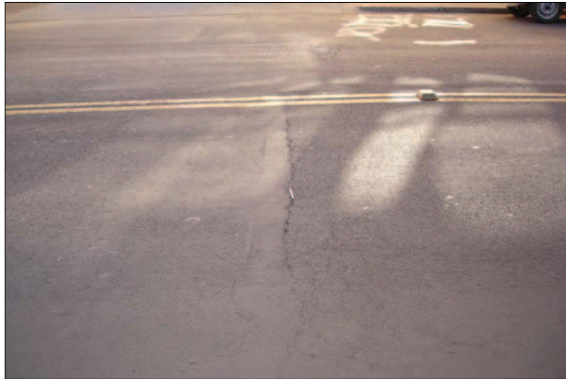
Figura 42 – Trincamento Transversal
