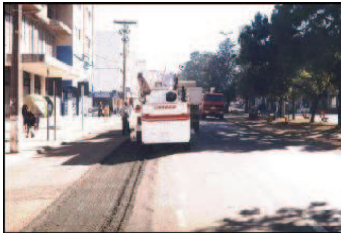
Figura 21 – Fresagem parcial
