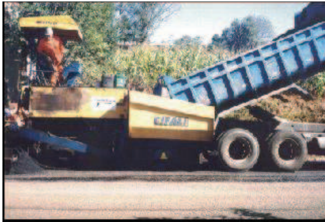
Figura 22 – Recapeamento em CBUQ
