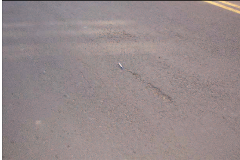
Figura 48 – Desagregação Superficial
