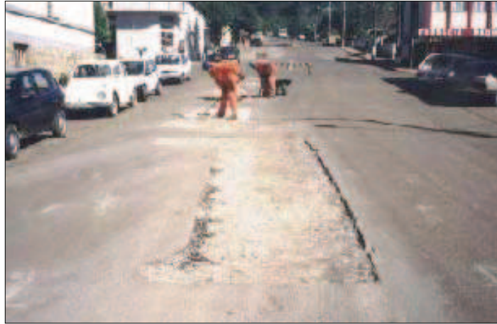
Figura 19 – Abertura de remendos superficiais em pavimento de CBUQ
