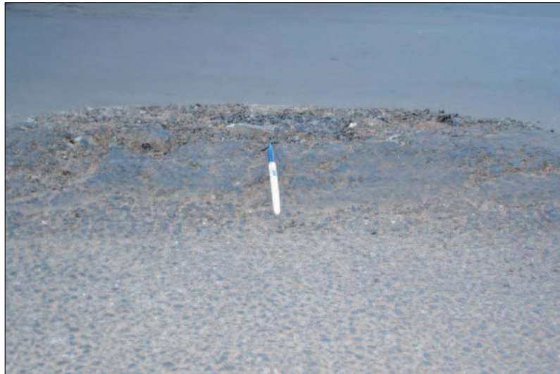
Figura 57 – Expansão Localizada
