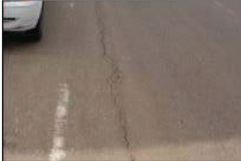
Figura 43 – Trincamento Longitudinal
