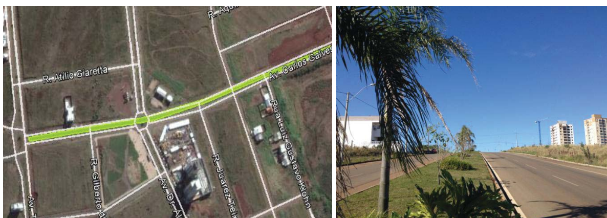
Figura 28– Canteiros da Avenida Carlos Galves.
