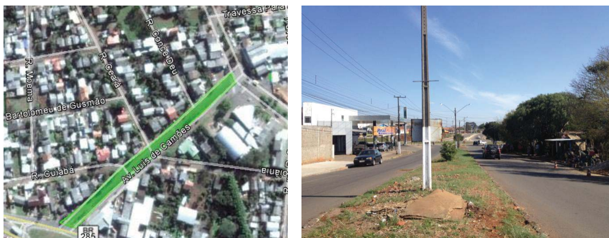
Figura 22 – Canteiros da Avenida Luís de Camões.
