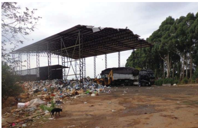
Figura 10: Vista da área de transbordo da Usina de São João da Bela Vista
