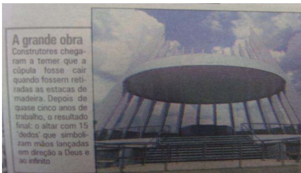
Figura 21: Estrutura do Altar-monumento
