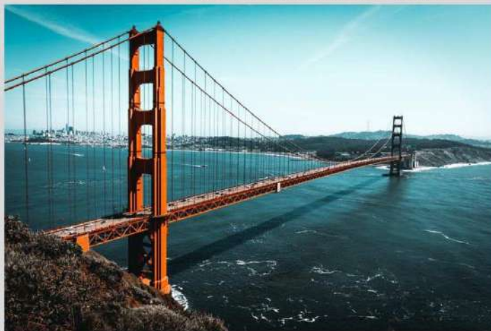
Ponte Golden Gate (São Francisco, Estados Unidos)
