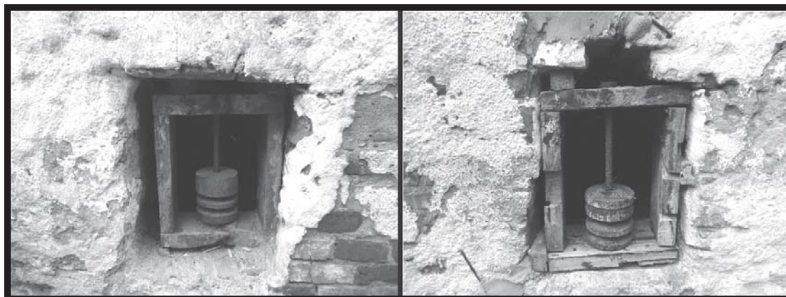
Figura 16 e 17 – Roldanas por onde passavam os cabos de aço do trapiche do armazém da companhia de navegação Arnt no porto de Muçum.
