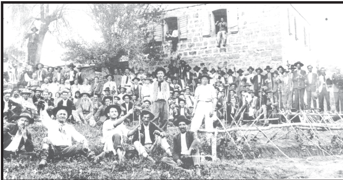
Figura 2 – Trabalho do imigrante na abertura de estradas. A foto apresenta imigrantes da colônia de Guaporé trabalhando na abertura da estrada Dr.Borges de Medeiros no início da década de 1900.
