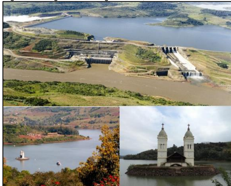
Figura 5 - Imagens da Barragem de Itá, Aratiba - RS
