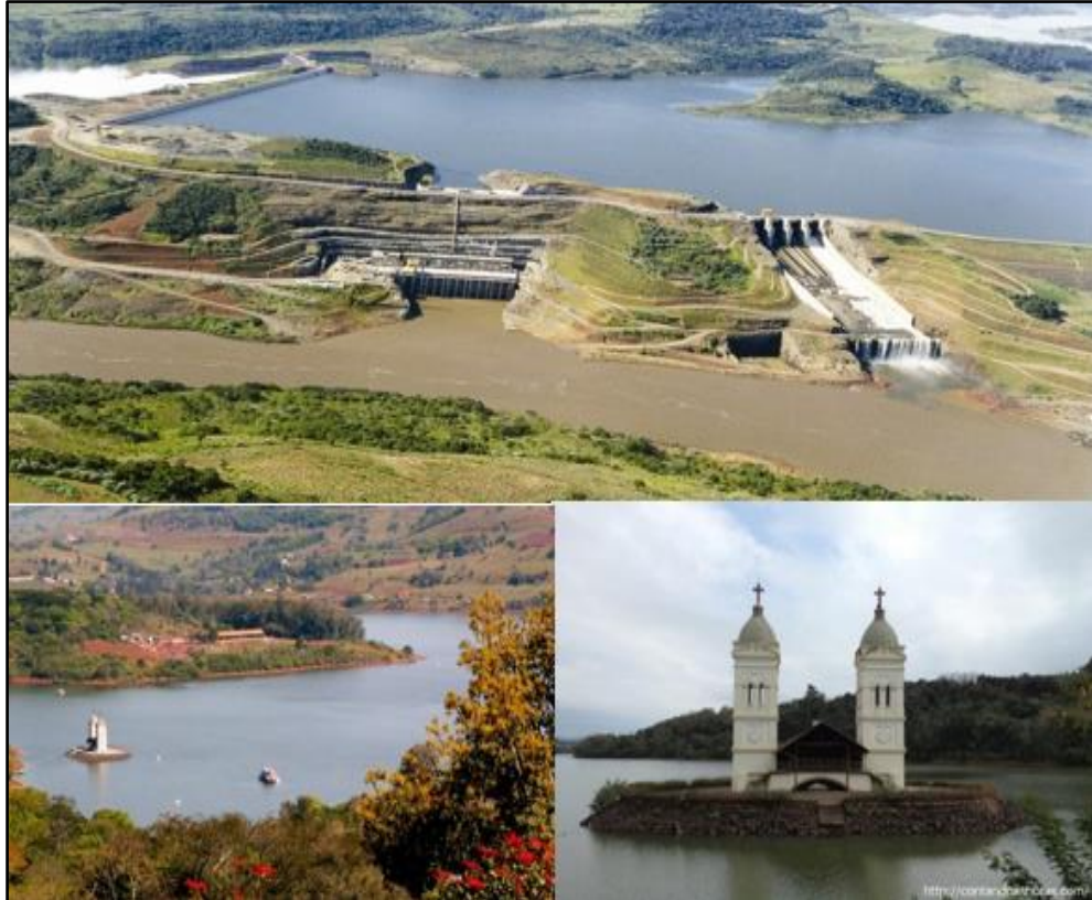
Figura 4 - Imagens da Barragem de Itá, Aratiba, RS
