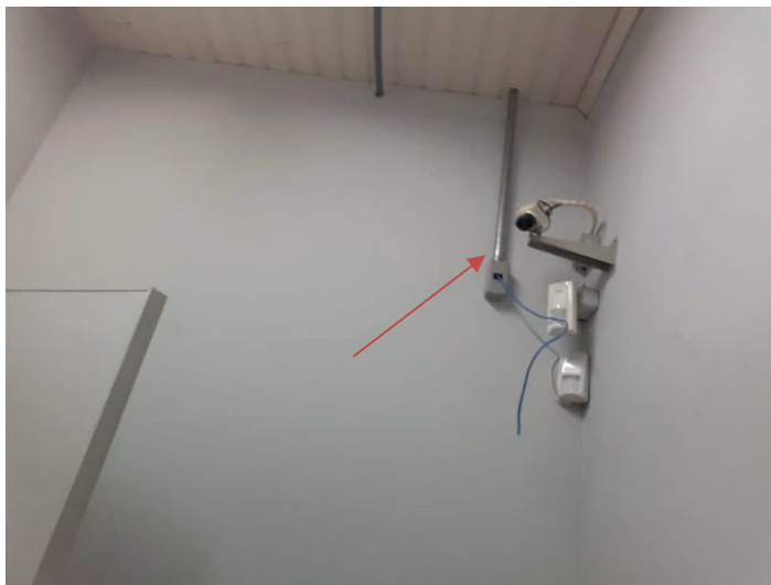
Figura 36: Execução de ponto lógico com a infraestrutura sobreposta.
