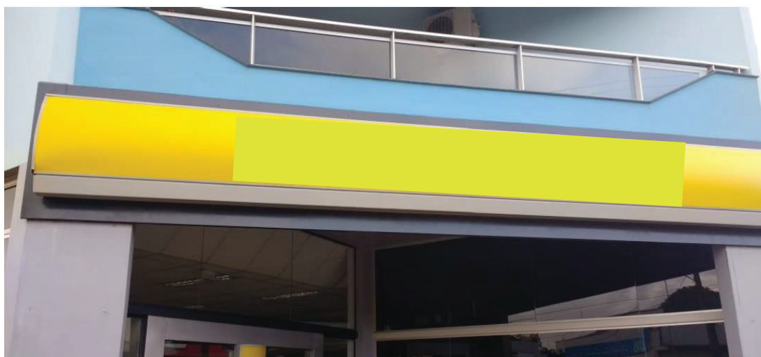
Figura 37: Execução de substituição da comunicação visual do letreiro de fachada.
