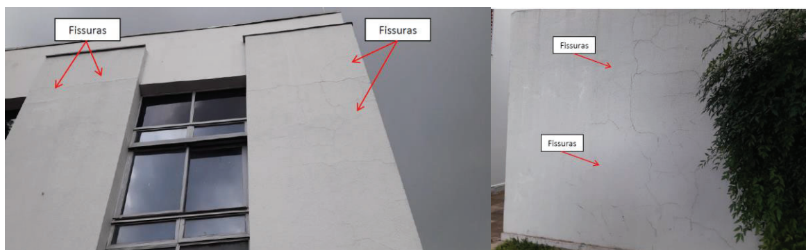
Figura 32: Parede apresentando avarias antes da recuperação e execução de pintura.
