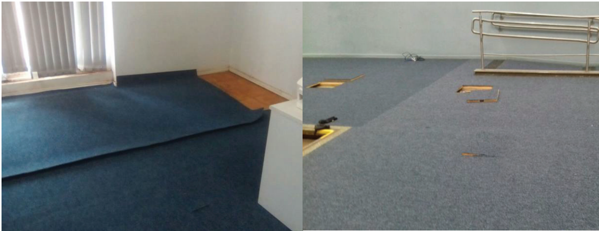
Figura 23: Piso carpete no processo de instalação
