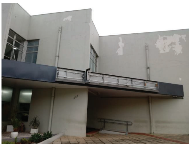
Figura 28: Letreiro que foi removido o policarbonato.
