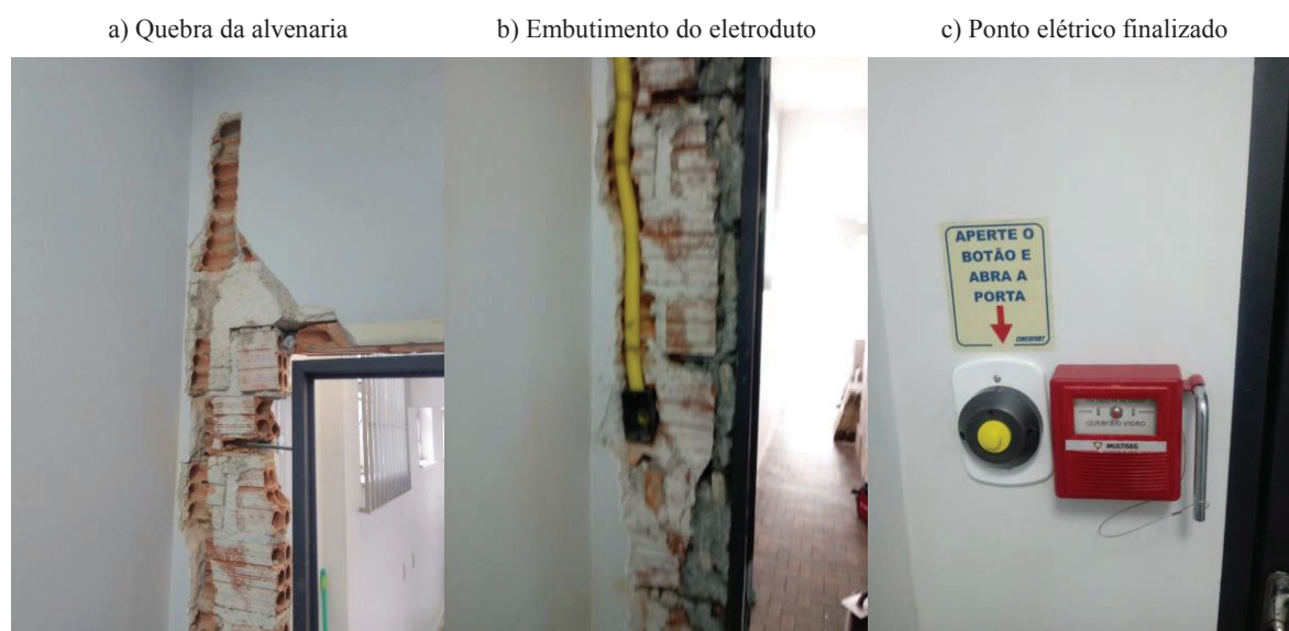
Figura 25: Detalhe de execução de um ponto elétrico
