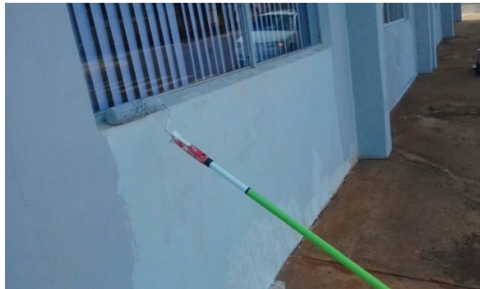
Figura 17: Execução de pintura acrílica sem emassamento
