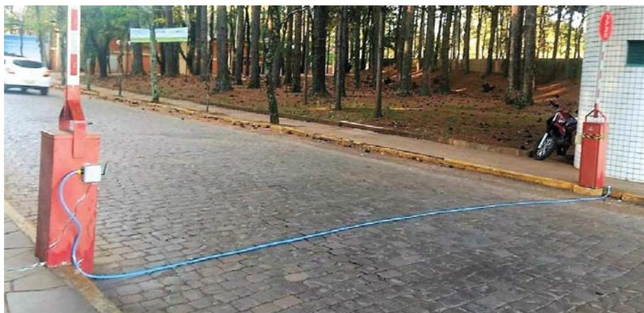
Figura 21. Instalação do Contador de Veículos
