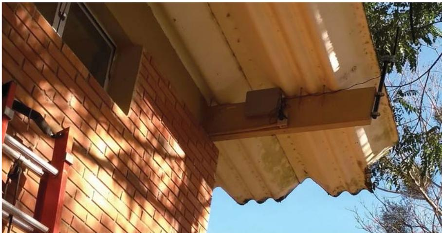
Figura 26. Gateway final instalado no local externo
