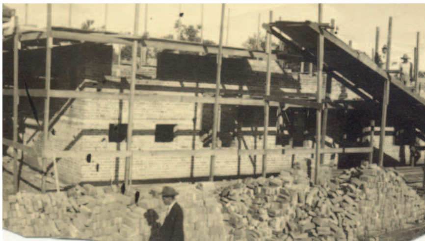
FOTO 4 - CONSTRUÇÃO DA SEDE DEFINITIVA DO CÍRCULO OPERÁRIO PASSOFUNDENSE, LOCALIZADO NA ESQUINA DA AVENIDA BRASIL COM A RUA MARCELINO RAMOS (INÍCIO DA DÉCADA DE 1940).
