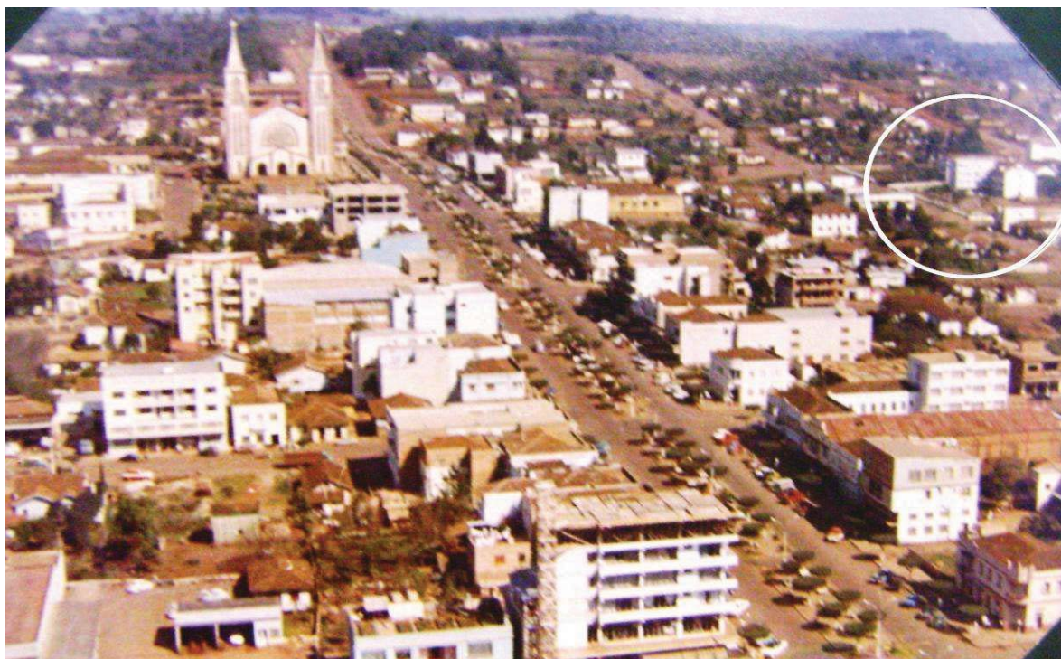
FIGURA 9. CENTRO DE CHAPECÓ/SC – COM DESTAQUE PARA O BOM PASTOR – 1965
