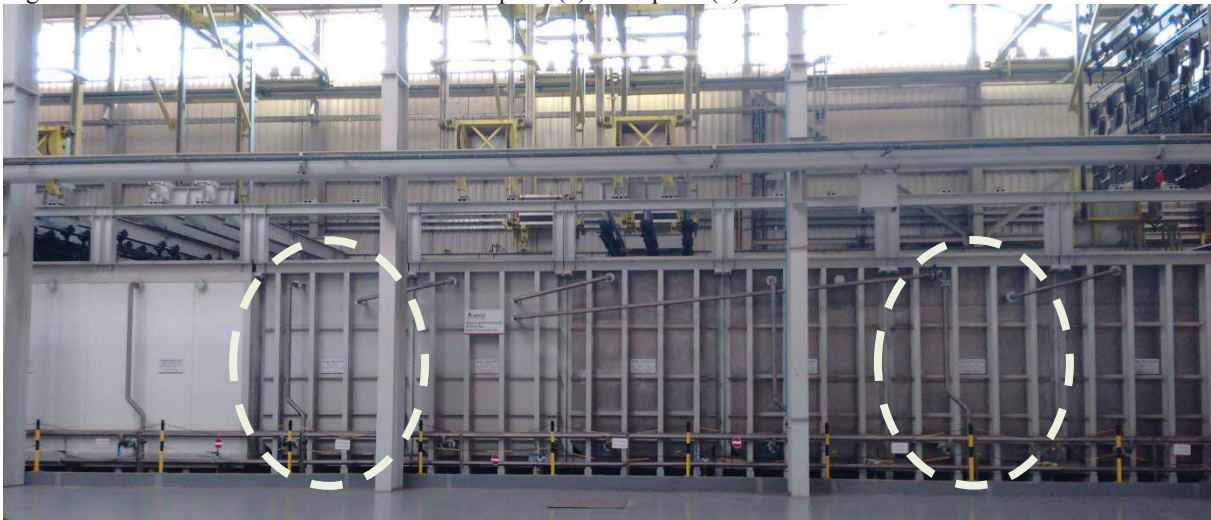
Figura 16 - Ponto de coleta do efluente do tanque 4 (a) e tanque 8 (b)
