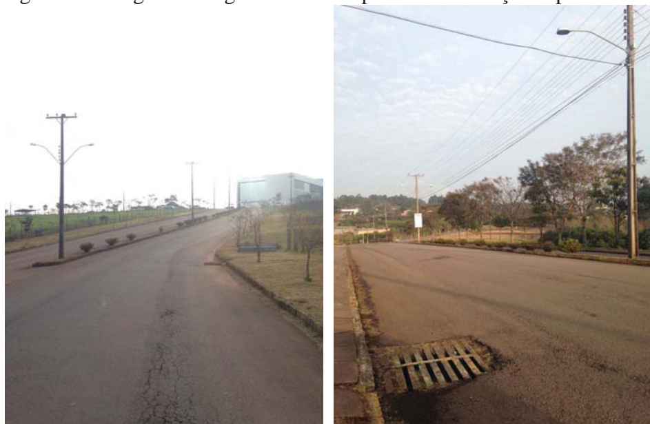
Figura 35 – Registro fotográfico das rampas com inclinação superior a 5%
