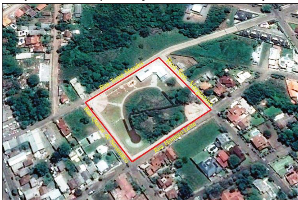
Figura 46 – Identificação do Parque Ambiental Banhado da Vergueiro.
