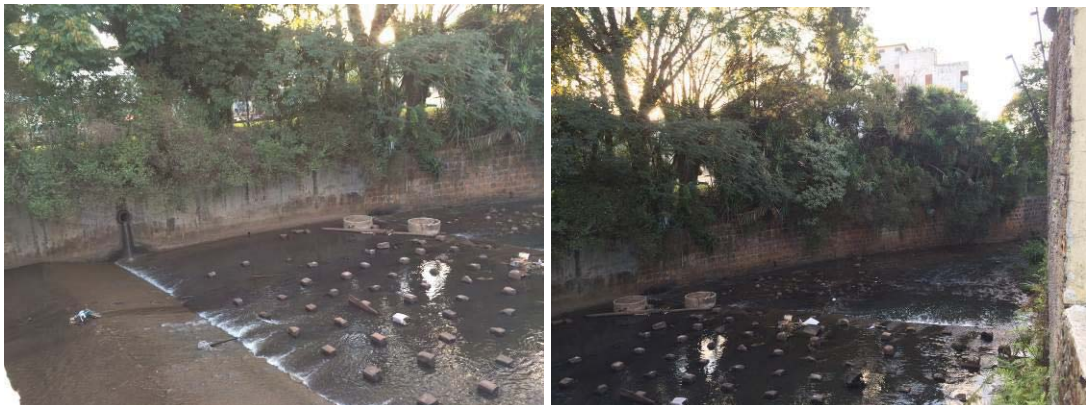
Figura 86 - Ponto 4: Leito do rio com lixo e lançamento de efluentes.
