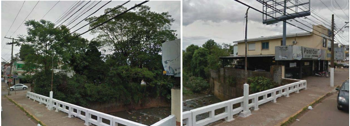
Figura 87 - Ponto 4: Vistas da APP. Edificações residenciais e mistas à esquerda e à direita.
