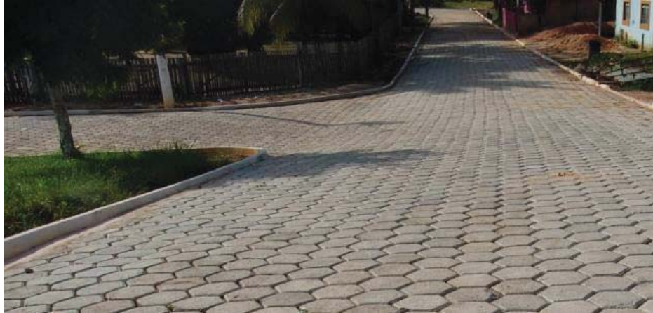
Figura 37 – Pavimentação permeável com piso intertravado de concreto.
