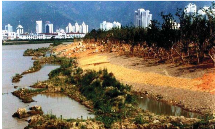
Figura 15 – Yongning River Park na cidade de Taizhou em desenvolvimento: concreto removido e terrenos estabilizados.
