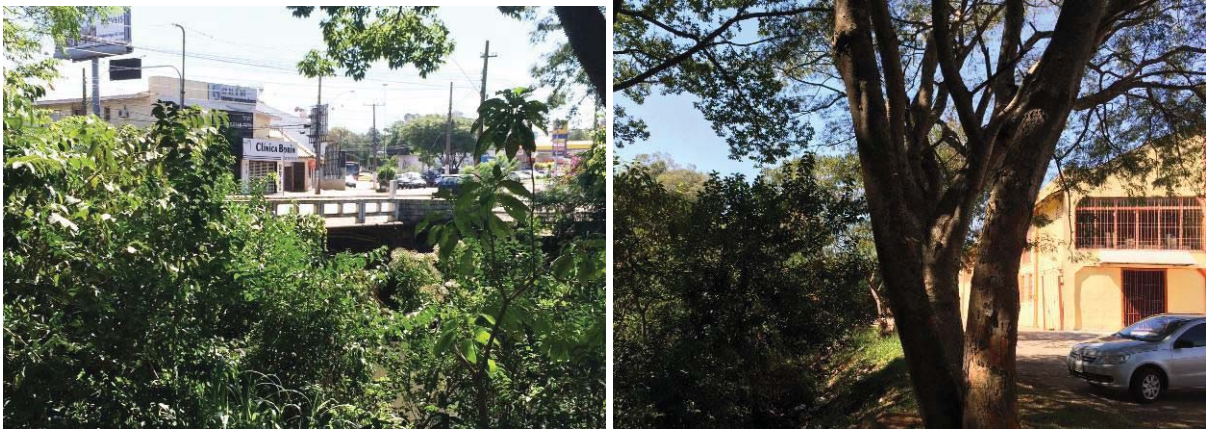
Figura 92 - Vistas dos fundos da praça da literatura. À esquerda ponte sob a Avenida Brasil que substituiu a histórica ponte de pedras. À direita edificação comercial junto da APP.
