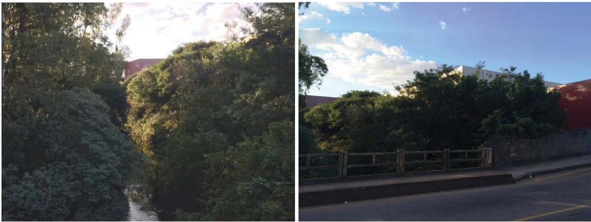
Figura 94- Ponto 6: Vista do rio e da edificação comercial (hipermercado) na APP à sua direita.
