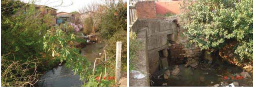
Figura 43 – A: Edificações em APP do rio Passo Fundo; B: Lançamento de esgoto no rio.
