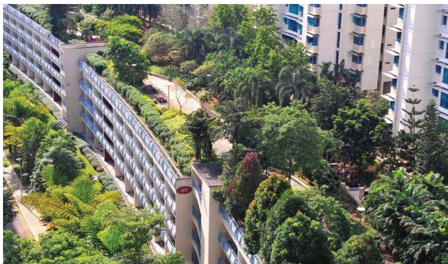
Figura 38 – Terraço verde implantado em edifícios.
