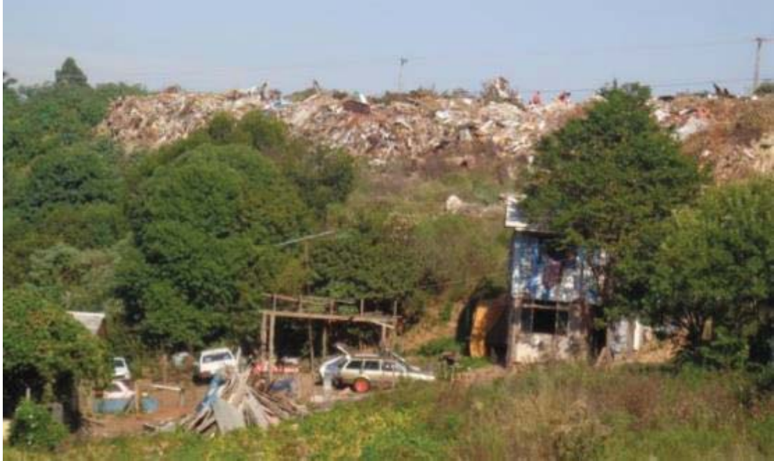
Figura 13: Local de depósito dos resíduos sólidos de construção civil de Passo Fundo
