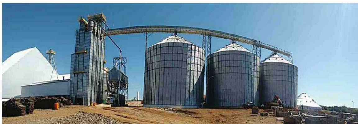
Figura 29 - Exemplo Unidade Armazenadora de Cereais.
