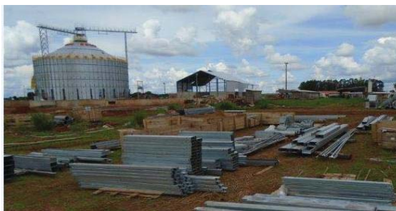
Figura 30 - Exemplo Organização do Material no Canteiro de Obra.
