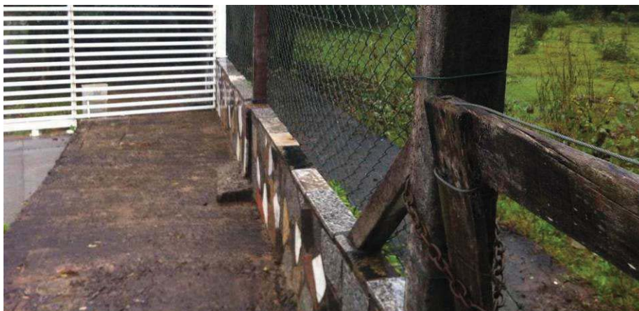
Figura 83 - Limite da galeria e muro construído sobre ela na Vila Floresta
