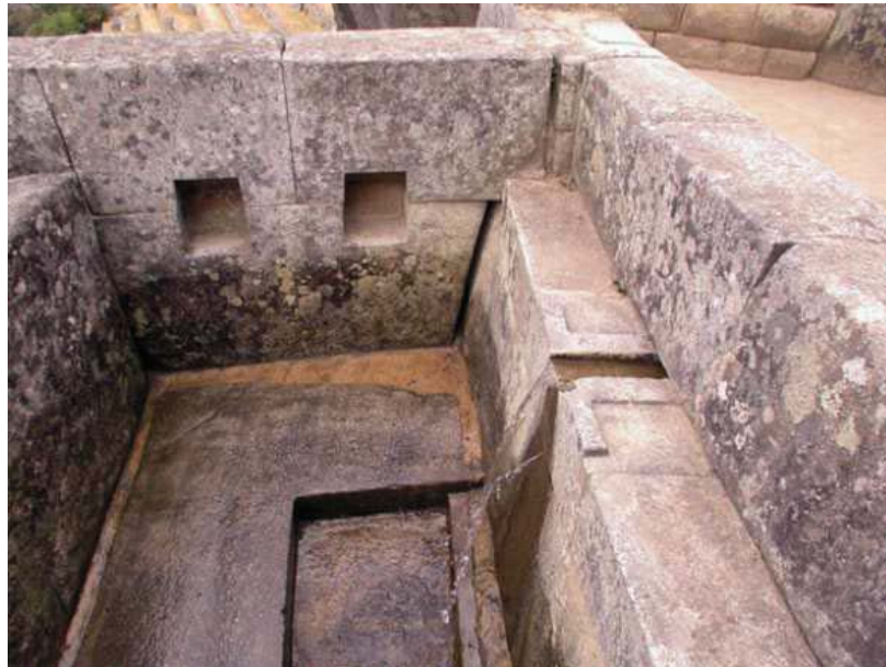
Figura 1 Sistema de drenagem na cidade inca de Machu Pichu
