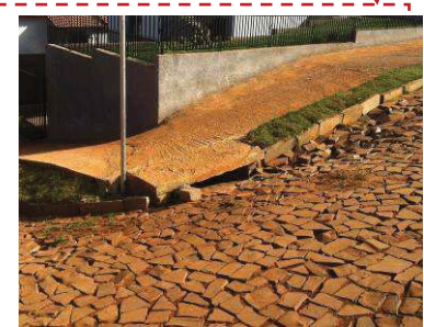
BOCA DE LOBO 3
