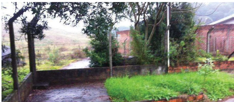
Figura 84 – Edificação iniciada e abandonada sobre a APP da Vila Floresta
