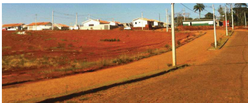
Figura 79 – Vista da Rua Dr.Hiran Sampaio, entrada do Núcleo Rio Tigre
