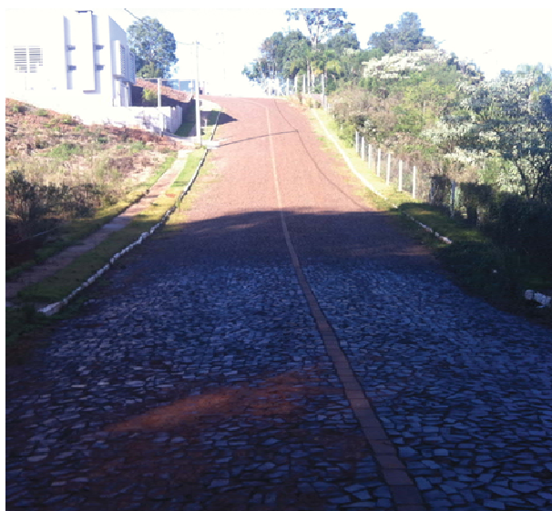
Figura 60 - Primeiro entroncamento da Rua "A"- Villaggio
