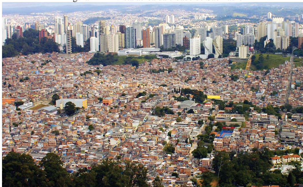
Figura 21 — Vista aérea da cidade de São Paulo
