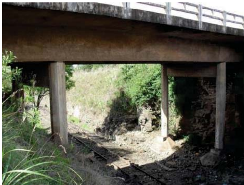
Figura 13: Mesoestrutura e Infraestrutura do Viaduto Estudado
