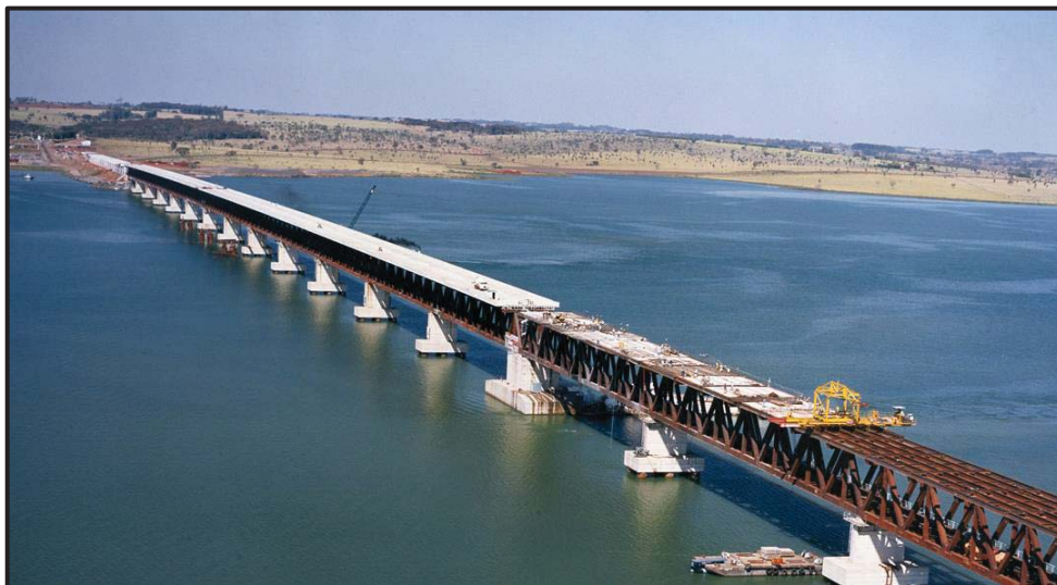
Figura 4 – Ponte rodoferroviária sobre o Rio Paraná
