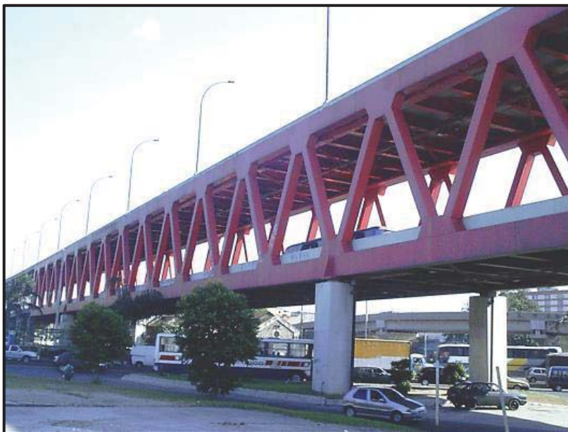
Figura 3 – Viaduto na Linha Vermelha – Rio de Janeiro
