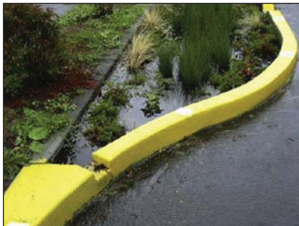
Figura 6 - Wetland construída em Portland, Oregon, Estados Unidos.
