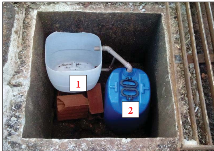
Figura 17 - Instalação do sistema para a coleta de água de chuva no estacionamento.
