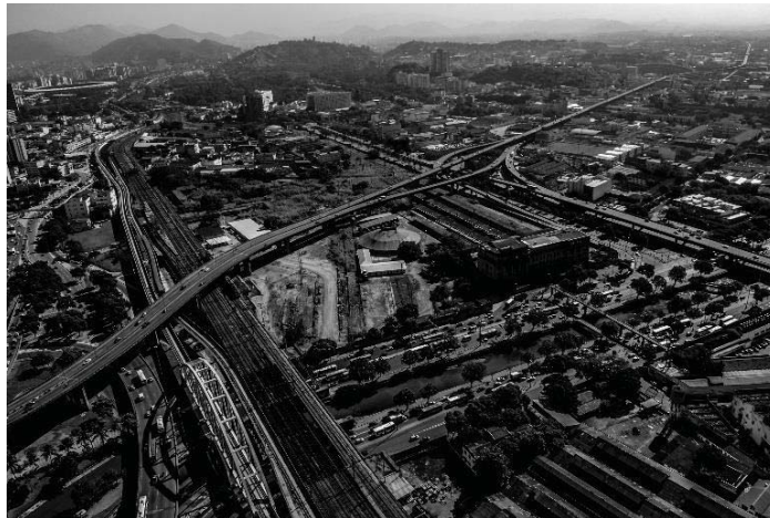
Figura 2. Viaduto Engenheiro Freyssinet.
