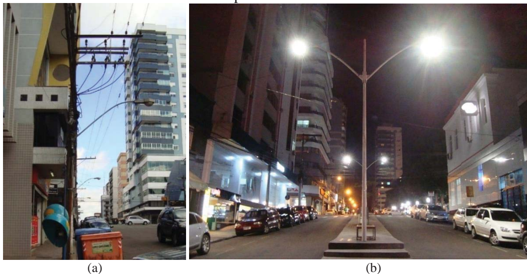
Figura 27 - Rua Independência (Passo Fundo), com utilização de postes com lâmpada de vapor de sódio
