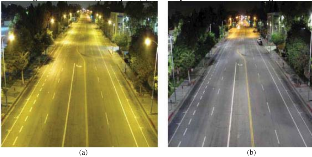
Figura 35 - Antes (a) e depois (b) do retrofit realizado em Los Angeles
