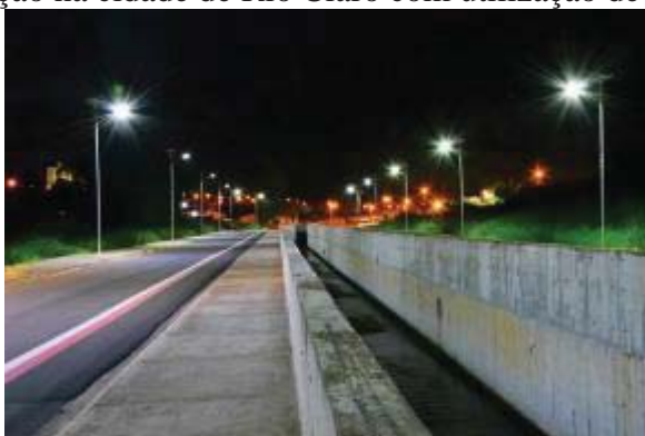
Figura 38 - Iluminação na cidade de Rio Claro com utilização de painéis fotovoltaicos
