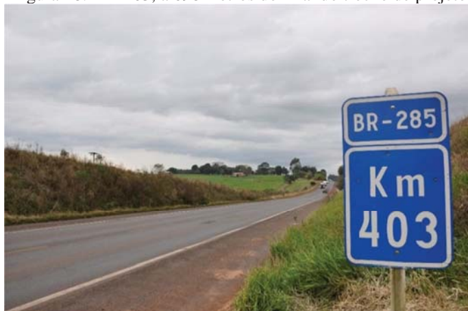
Figura 18: Km 403, a 698 metros do final do trecho de projeto
