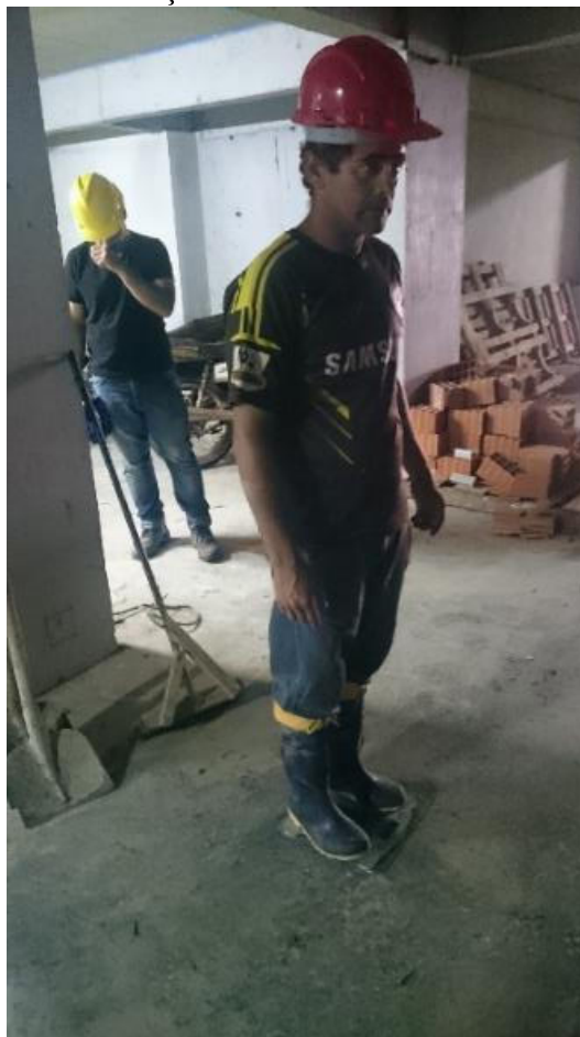
Figura 20: Verificação da massa de um dos trabalhadores
