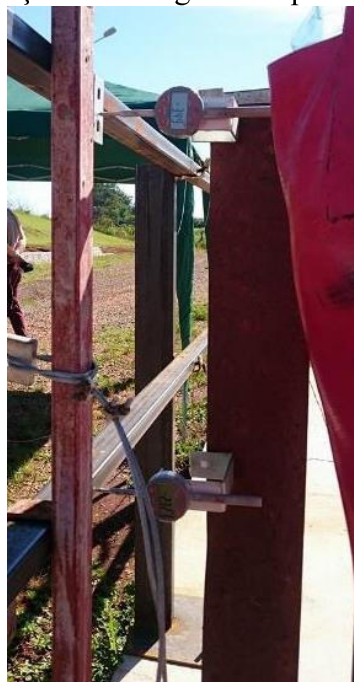
Figura 46: Instalação dos relógios comparadores na estrutura
