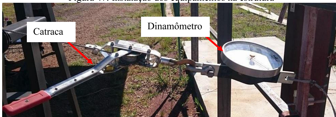
Figura 47: Instalação dos equipamentos na estrutura
