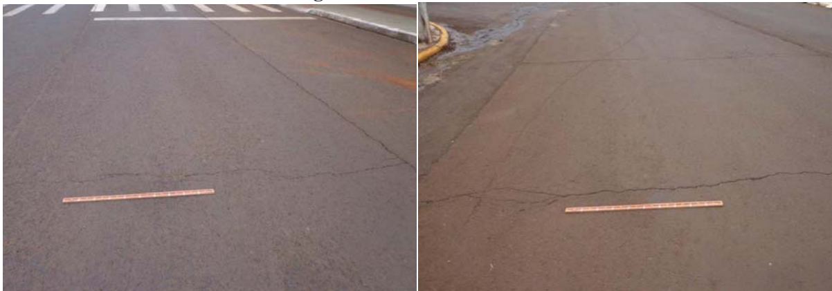
Figura 18 - Trinca transversal
