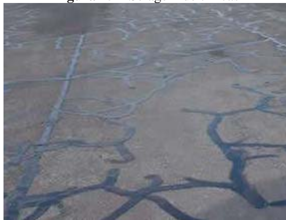
Figura 15 – Selagem de trincas
