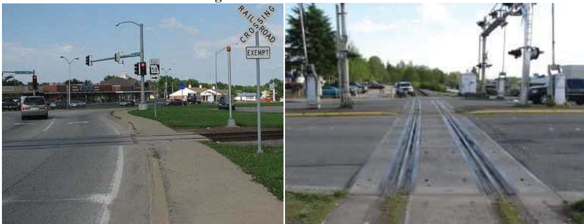
Figura 23 – Cruzamento de linha férrea
