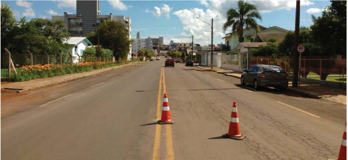
Figura 51 – Vista da rua Joinville: seção 8
