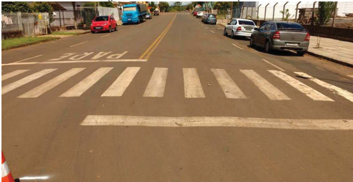
Figura 50 – Vista da rua Amazonas: seção 7
