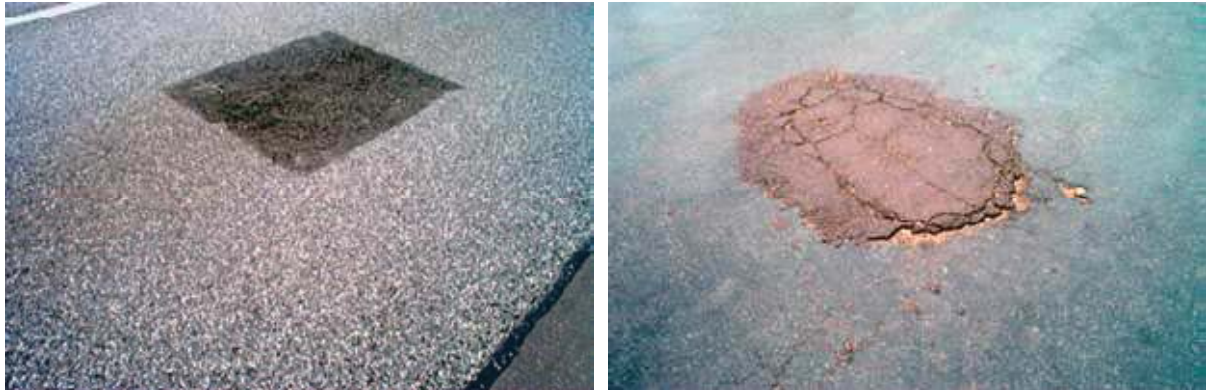
a) Remendo de conservação padrão
