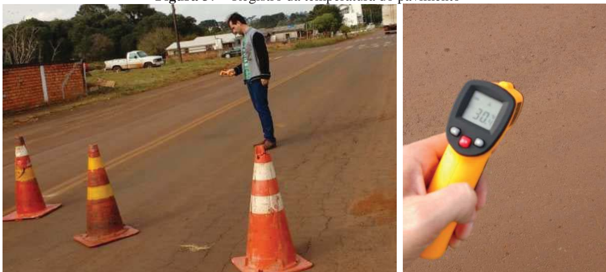
Figura 37 – Registro da temperatura do pavimento
