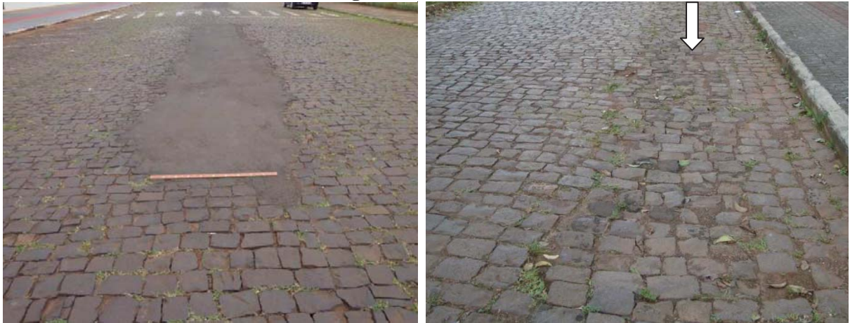
Figura 30 – Remendo
