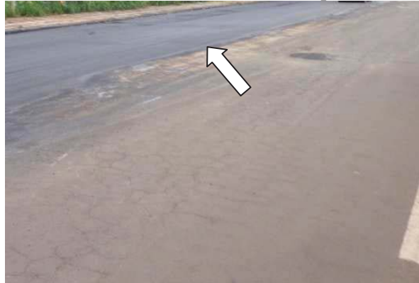
Figura 13 – Remendo considerado como pavimento novo
