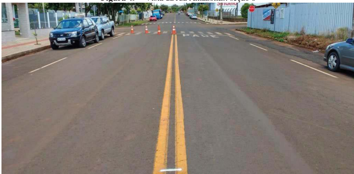
Figura 49 – Vista da rua Amazonas: seção 6
