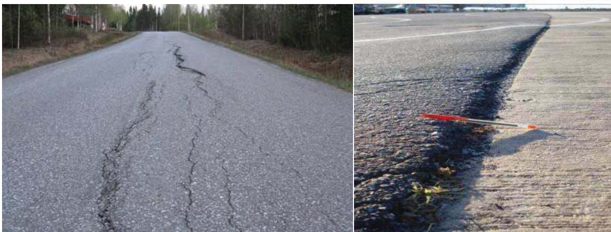
Figura 22 – Inchamento do pavimento
