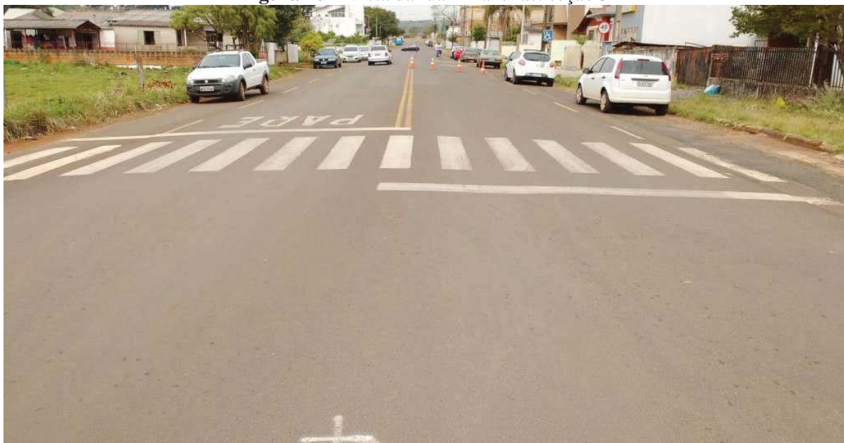
Figura 48 – Vista da rua Amazonas: seção 5
