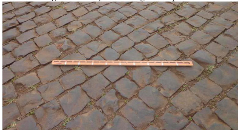
Figura 29 - Peças com desgaste ou polidas
