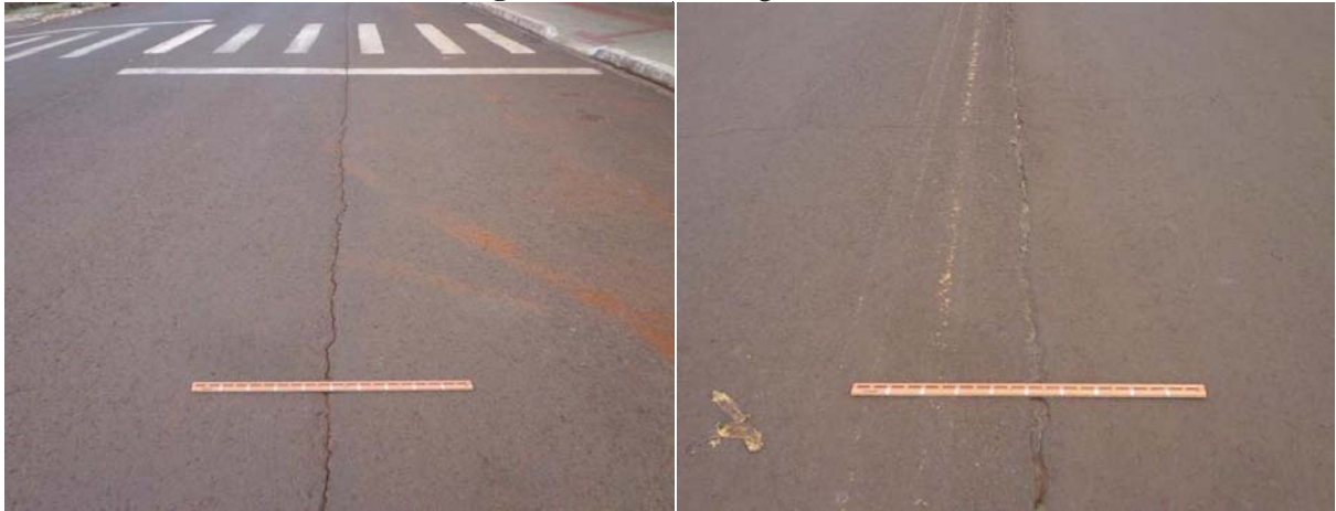
Figura 17 - Trinca longitudinal
