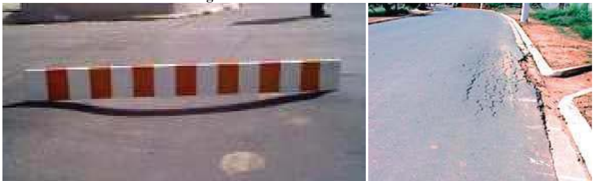
Figura 2 - Afundamento localizado
