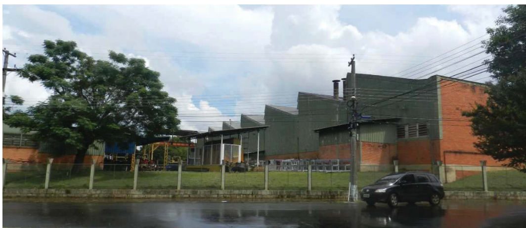
Figura 36 - Vista da rua onde se dá o acesso principal à empresa, que ocupa todo um quarteirão
