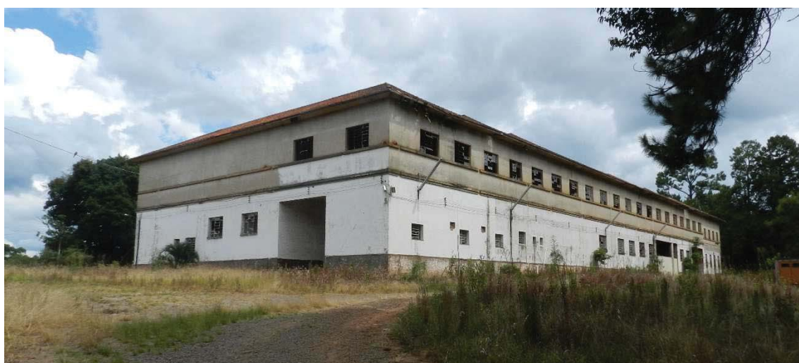
Figura 34 - Primeiro antigo frigorífico a ser visitado
