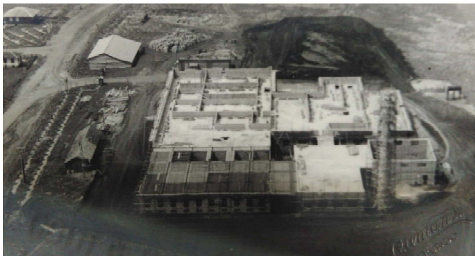
Figura 32 - Frigorífico 1 no momento de sua construção
