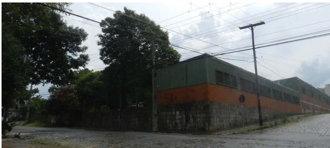
Figura 35 - Vista de uma das extremidades do prédio da empresa metalúrgica
